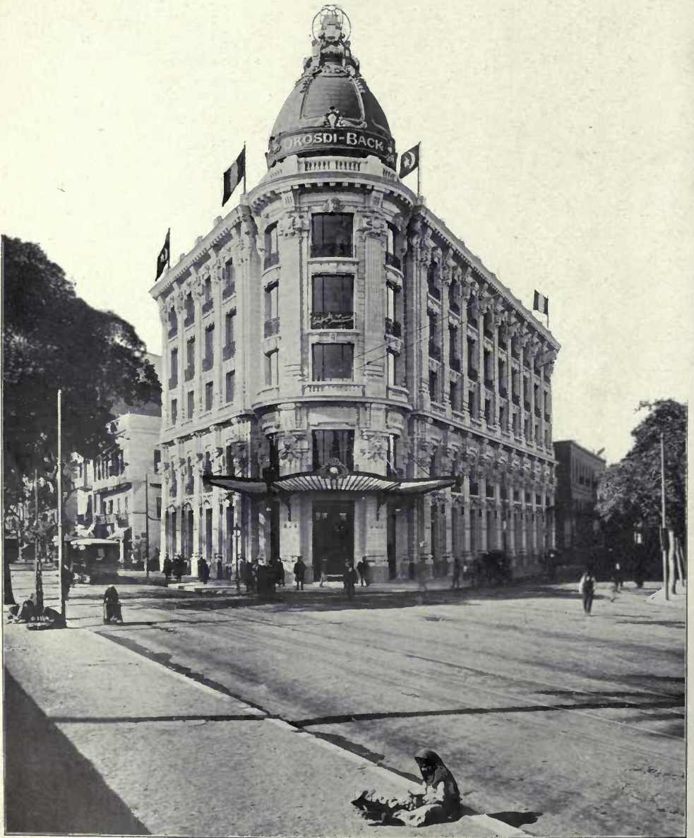
4059. Palais Omer Effendi, nouveaux magasins des établissements Orosdi-Back, au Caire (Egypte), RAOUL J. E. BRANDON, Architecte.
