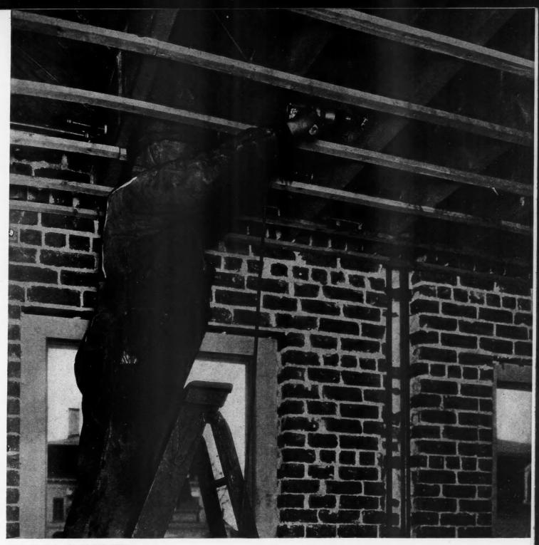
ELECTRIC JOIST BORING FOR PIPES
