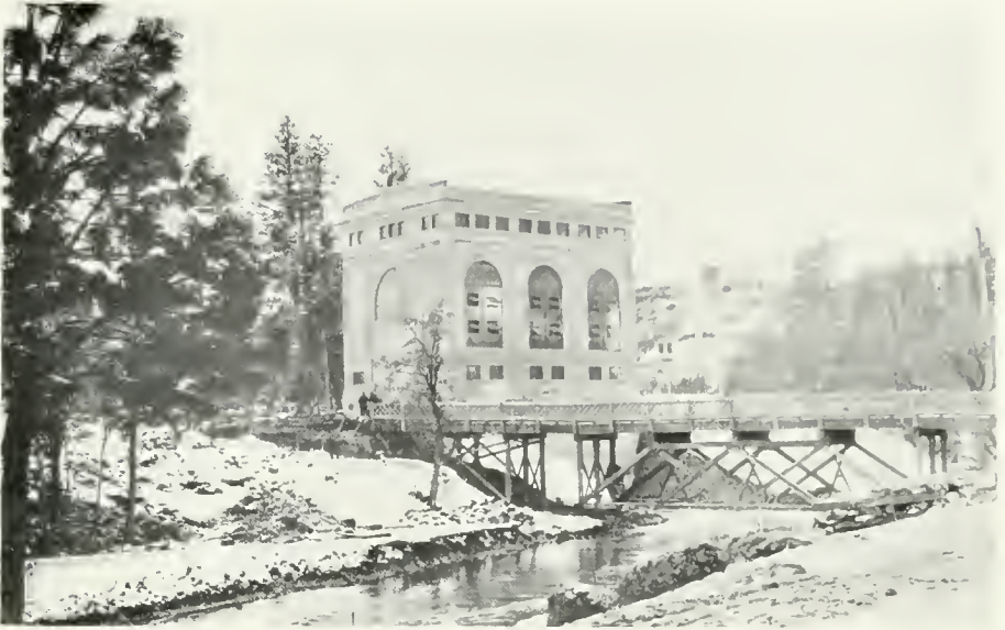
HAT CREEK POWER-HOUSE, No. 1
