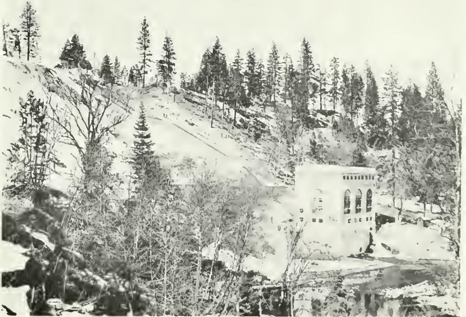
HAT CREEK POWER-HOUSE, No. 2
