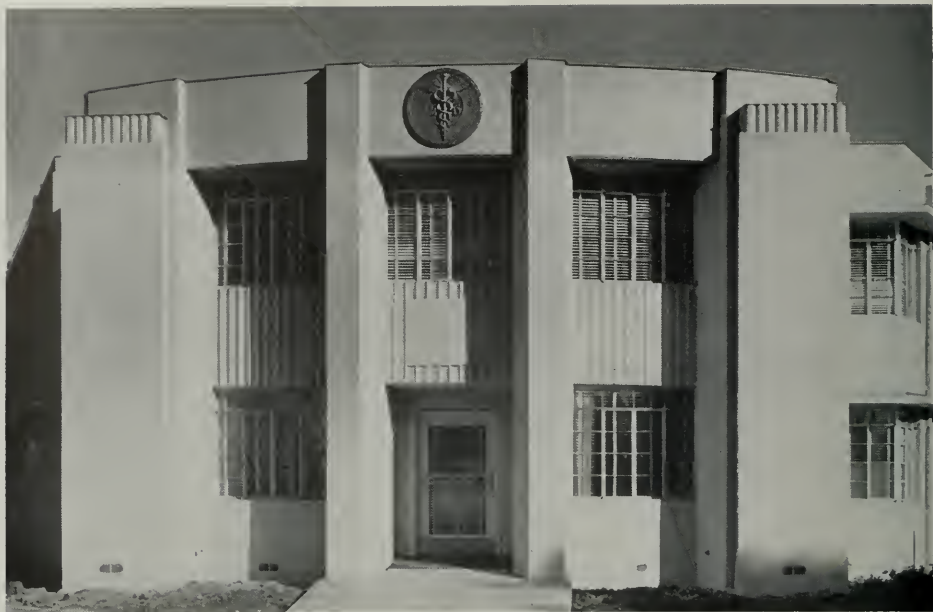
R. S. Knight, General Contractor
