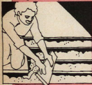
Installing loose fill
