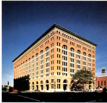
HARTMAN-COX: 800 N. Capitol Street.
