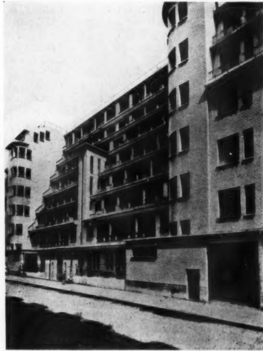
APARTMENTS, RUE DES AMIRAUX, PARIS
