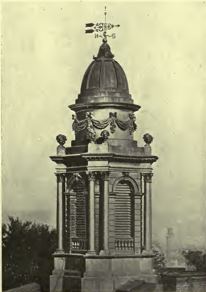
DETAIL OF TOWER—ALBANY (N. Y.) ACADEMY.
