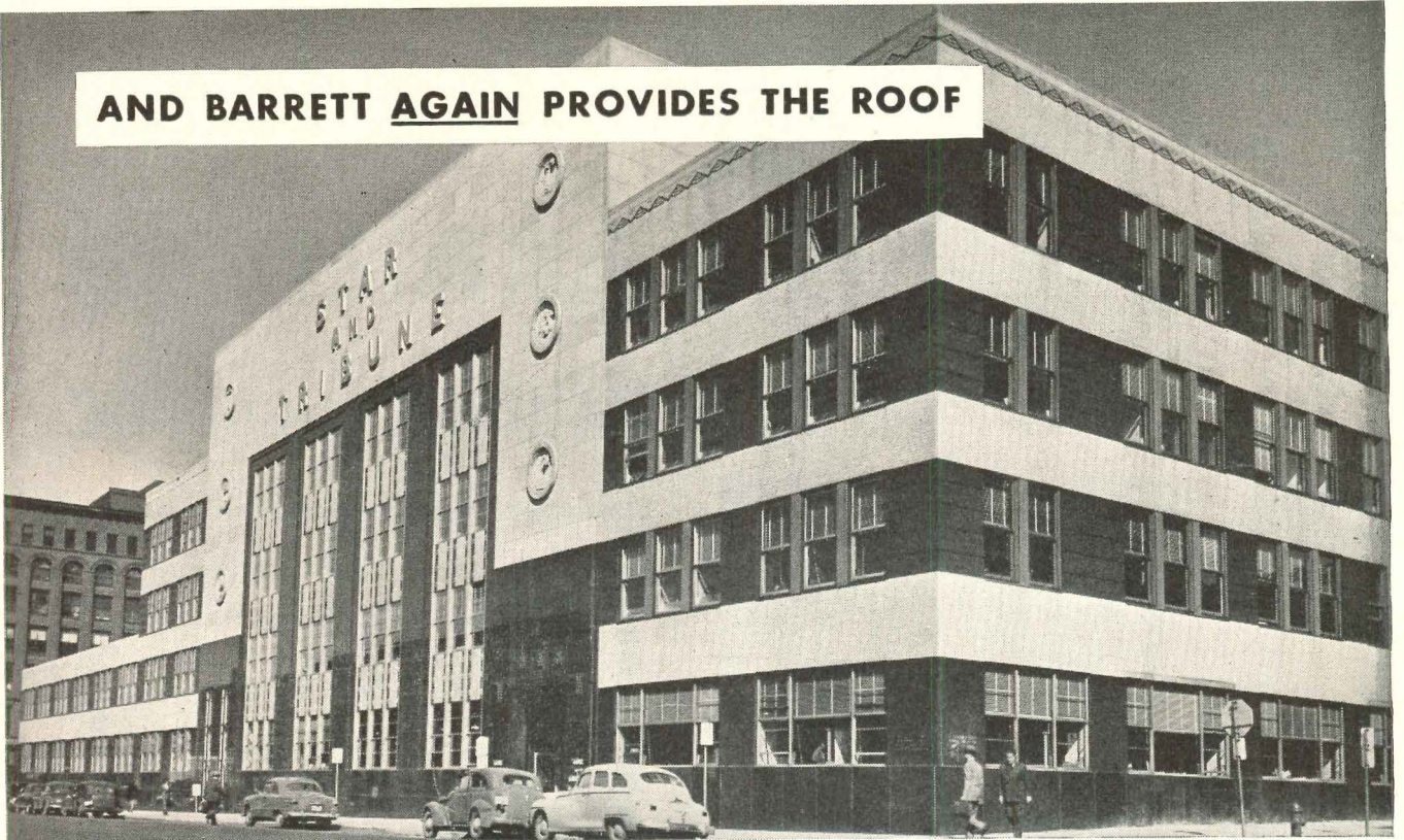
Arch.: Larson & McLaren, Gen. Cont.: F. F. Haglin & Sons Co., Roof. Cont.: John A. Dalsin & Son. All of Minneapolis.
