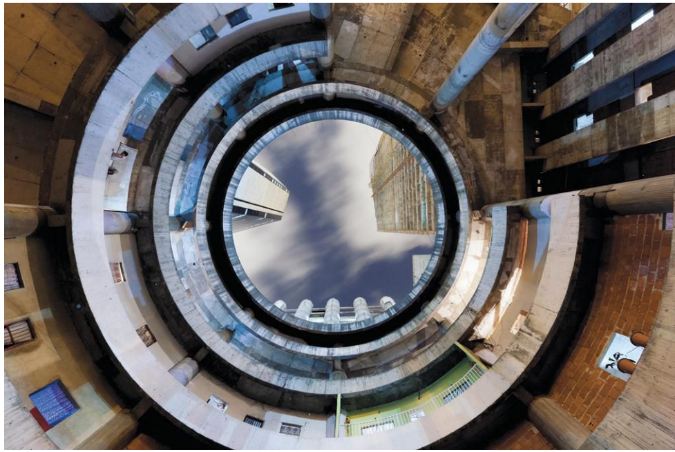
IWAN BAAN Torre David #2 , 2011
