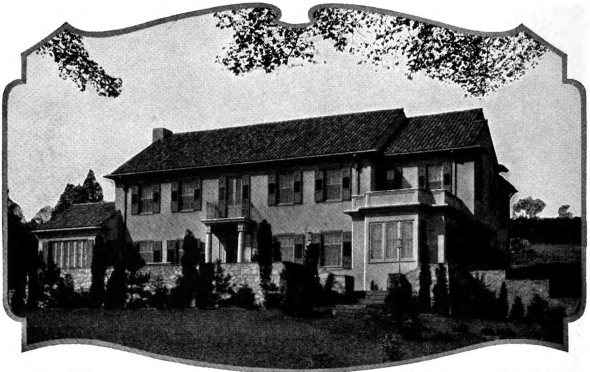
P. Magone Residence, Elmhurst, L. I.
