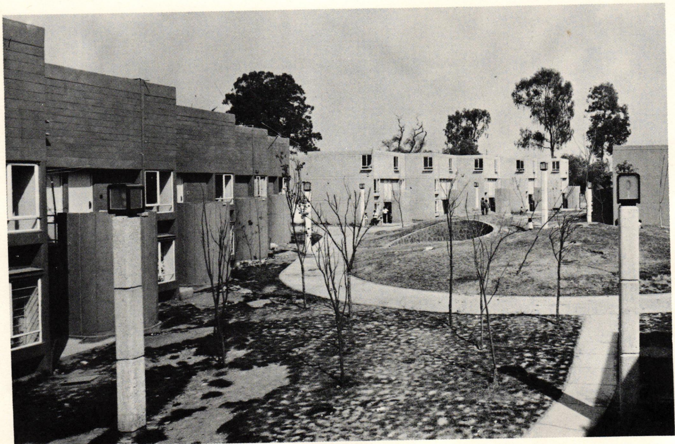
13 CASAS DE DOS PISOS Y ESPACIOS PEATONALES.
