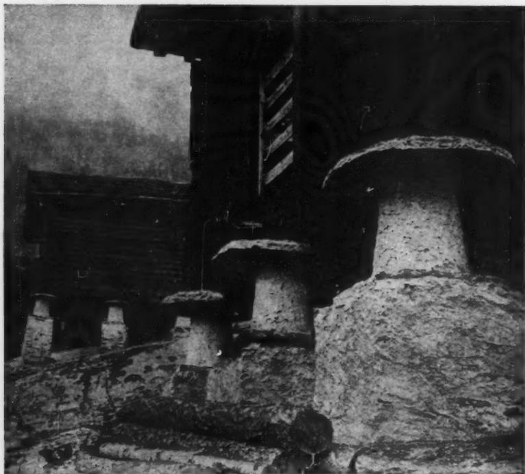
GRANGES A SANS FÉE, EN SUISSE. Les pilotis coiffés de dalles plates protègent les réserves de l'attaque des rats.
