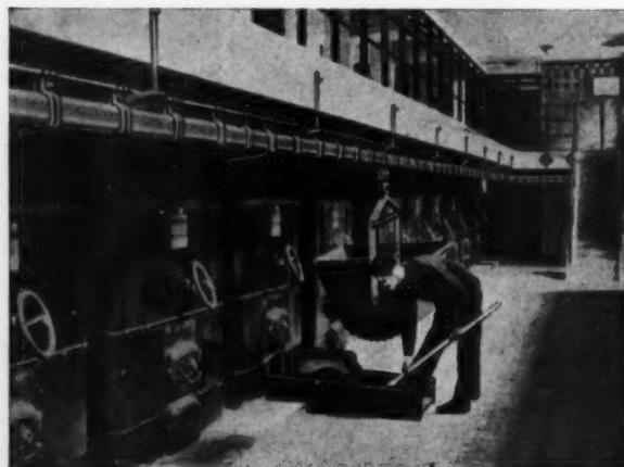
Fig. 2. Vue des chaudières de la même chaufferie. Un deuxième monorail (relié au monte-charge) sert au transport des scories.
