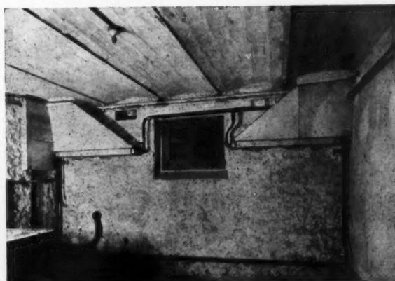
FIG. 5. APPAREILS CONVECTEURS PLACÉS DANS LE SOUS-SOL D'UN LOCAL A CHAUFFER.
