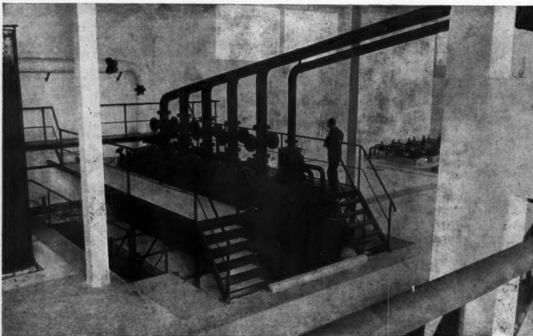
L'USINE DE DRANCY. TONNE DE RÉCEPTION ET TUYAUX CONDUISANT VERS LE RÉSERVOIR, AU-DESSUS DES ESSOREUSES
