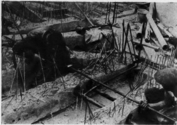
INSTALLATION DES CANALISATIONS DE CHAUFFAGE SOUS LE PLANCHER
