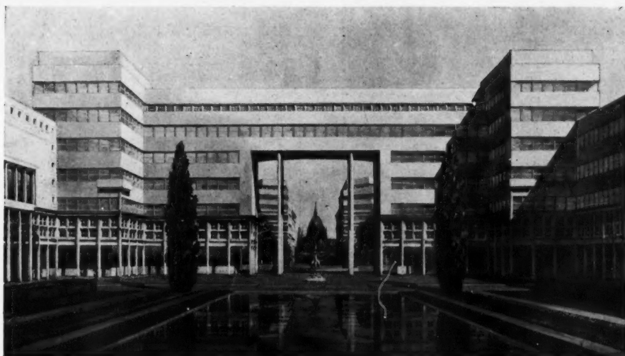
PLACE INTÉRIEURE DU NOUVEL HOTEL THERMAL, AXÉ SUR LE PALAIS DU PARLEMENT
