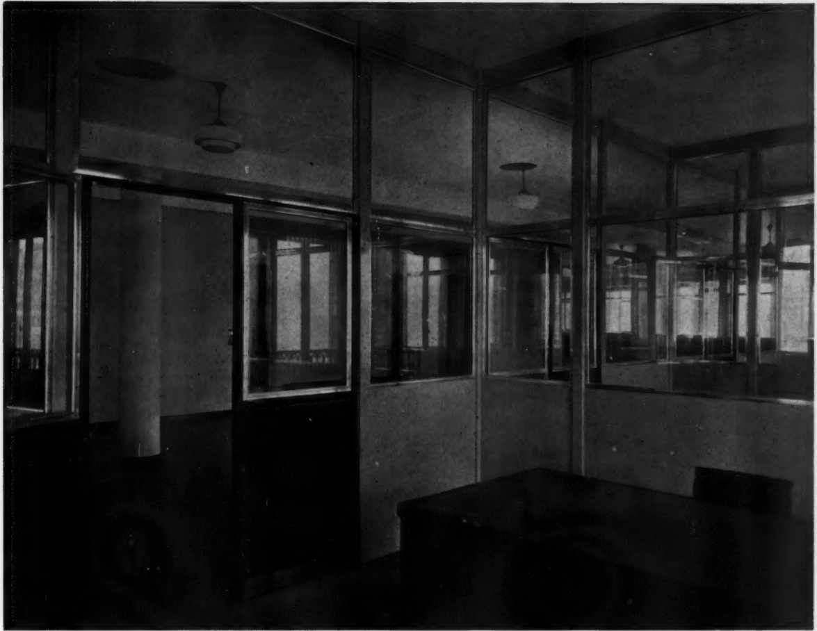
LES BUREAUX DU TROISIÈME ÉTAGE. Cloisons démontables.
