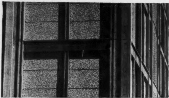
FIG. 33. — REVÊTEMENTS EN GALETS DE MARBRE (Cité de Drancy - Beaudoin et Lods, arch.)
