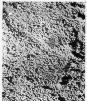
FIG. 13 et 14. — Texture obtenue en appliquant le mortier à la truelle tenue obliquement, sans appuyer.
