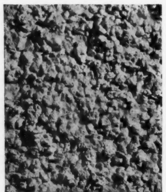
FIG. 19 et 20. — Texture obtenue par projection à la truelle sur une couche de ciment frais d'un mortier à fort pourcentage de gravillons.
