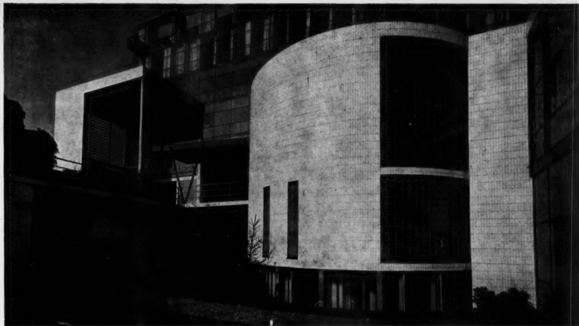
FIG. 1. — HALL D'ENTRÉE DE LA CITÉ DE REFUGE DE L'ARMÉE DU SALUT
