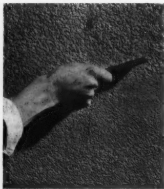
FIG. 11. — Aspect d'un enduit tyrolien aplani à la truelle. FIG. 12. — Aspect d'un enduit lisse frotté de bas en haut avec un bloc de bois.
