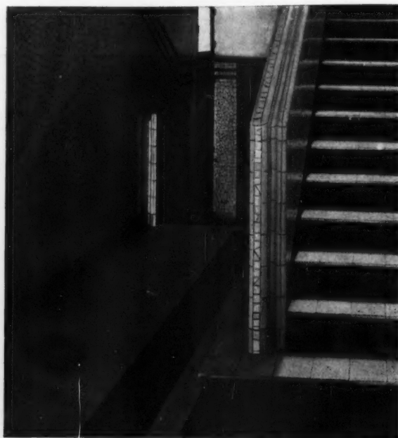
FIG. 2. — SOL EN GRÈS CÉRAMÉ. MARCHES EN GRÈS STRIÉ. MURS EN FAÏENCE OPUS-INCERTUM. PIÈCES SPÉCIALES POUR RAMPE
