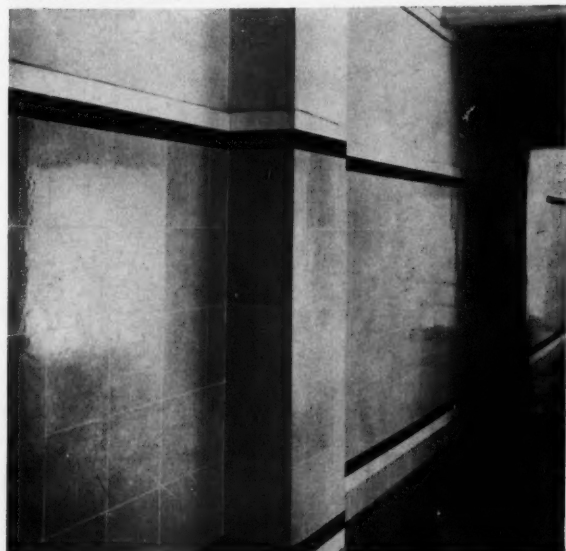
REVÊTEMENT DE COULOIR EN CARREAUX 30 × 30 DE MARBRITE (ARCH.: SIX)
