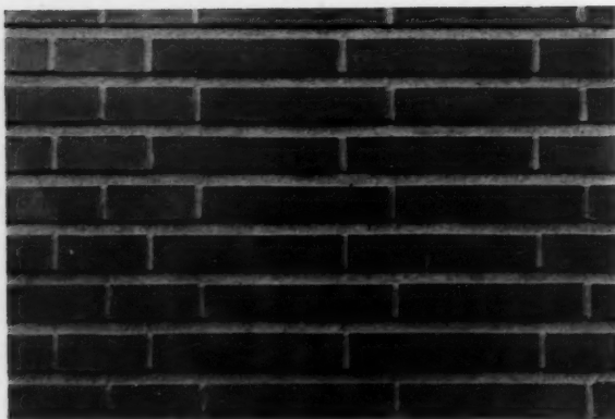
BRIQUE LISSE HY ROUGE PASTEL BRIQUETAGE SUÉDOIS (deux panneresses, une boutisse). Joints verticaux minimum, au nu du parement, ton gris. Joints horizontaux 15 mm., à plat, ton neutre gris.
