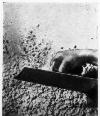
FIG. 13 et 14. — Texture obtenue en appliquant le mortier à la truelle tenue obliquement, sans appuyer.
