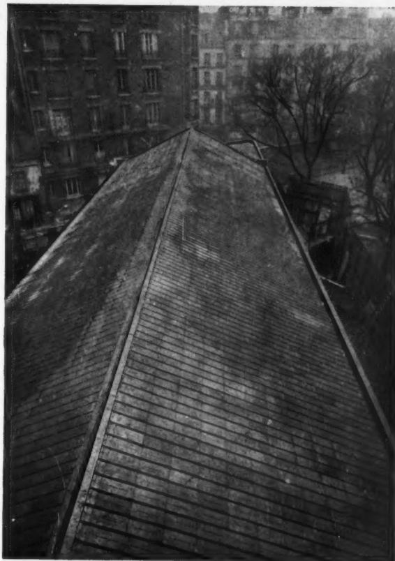
SALLE DE GYMNASTIQUE DU LYCÉE HENRI IV A PARIS Tuiles à double recouvrement. Epaisseur: 4/10.
