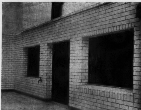
FIG. 5. — BRIQUES ÉMAILLÉES NORMALES ET ARRONDIES
