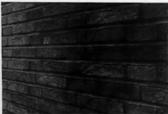
BRIQUE SABLÉE GRIS BRUN BRIQUETAGE HOLLANDAIS Joints verticaux minimum au nu du parement. Joints horizontaux obliques de 15 mm., ton noir.
