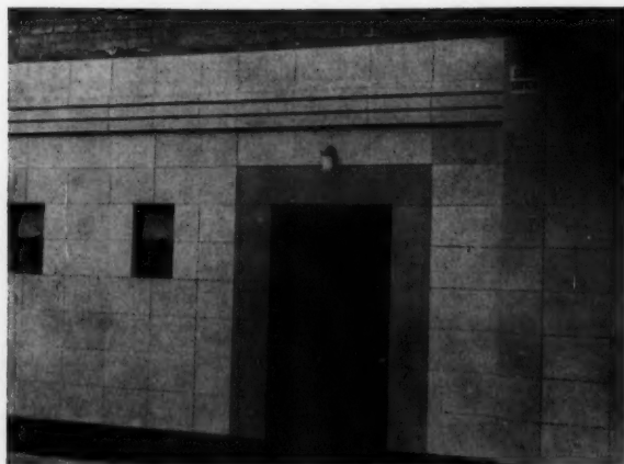
FIG. 2. — PLAQUES DE GRÈS ÉMAILLÉ de grandes dimensions dont l'emploi commence à se répandre en France.
