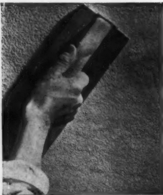
FIG. 9 ET 10. — ENDUIT TYROLIEN 1° Pose à la truelle d'une mince couche de finissage. 2° Projection du mortier à la brosse dure.
