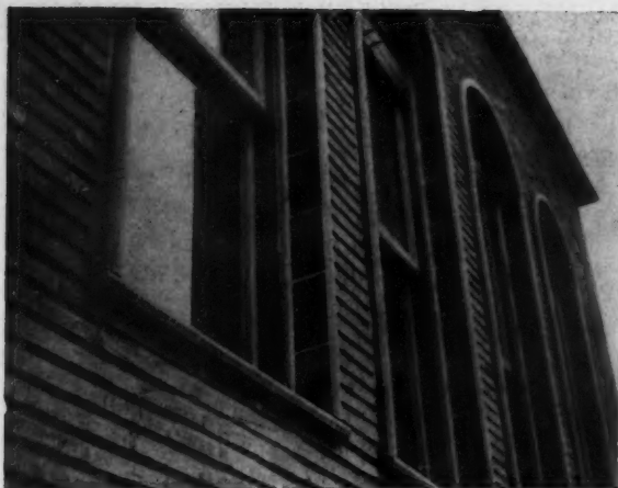
FIG. 4. — ENCADREMENTS ET APPUIS DE BAIES EN CÉRAMIQUE
