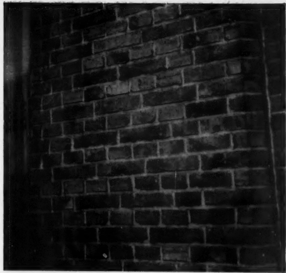
BRIQUE SABLÉE FORMAT BELGE Briquetage alterné en croix.
