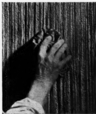
FIG. 21 et 22. — Texture obtenue au moyen d'une brosse très dure sur ciment frais. Légèrement essuyé ensuite.
