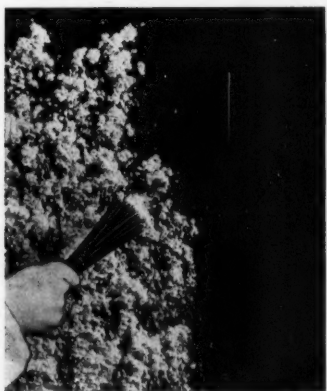
FIG. 21 et 22. — Texture obtenue au moyen d'une brosse très dure sur ciment frais. Légèrement essuyé ensuite.
