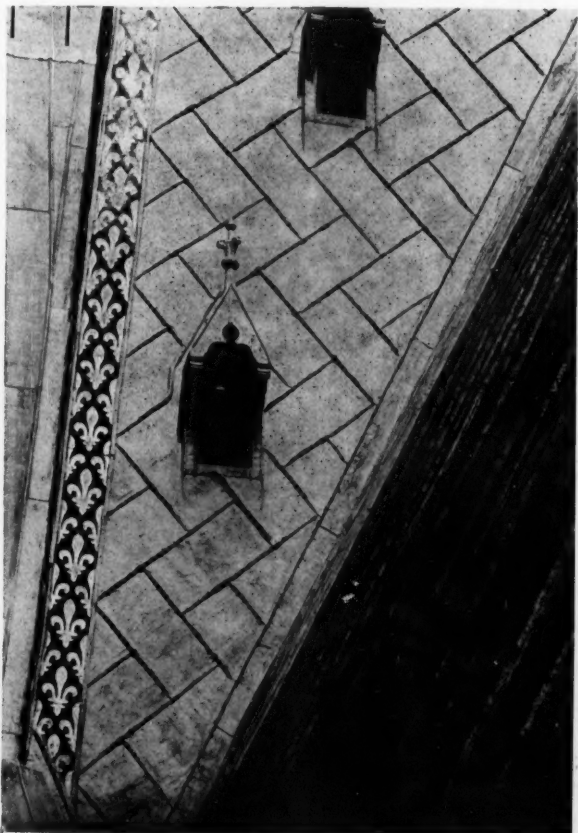
PLANCHE XIV. — DÉTAILS PHOTOGRAPHIQUES DE LA COUVERTURE A BATONS ROMPUS ET DU DÉCOR DU MÉTAL
