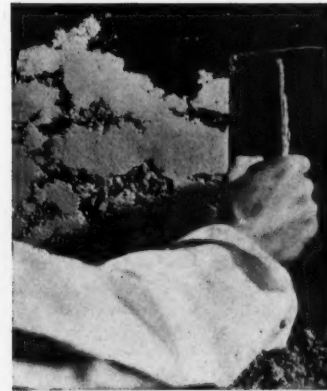
FIG. 23 et 24. — Texture obtenue au moyen d'une brosse spéciale (pointes en caoutchouc).
