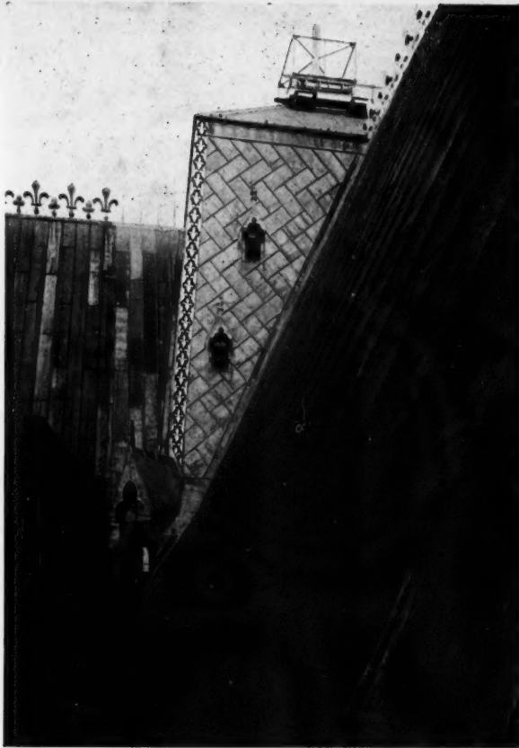
PLANCHE XII. — PHOTOGRAPHIE DE LA COUVERTURE A BATONS ROMPUS
