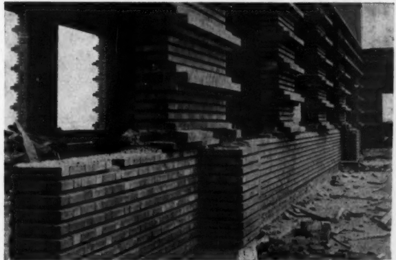
BRIQUES SPÉCIALES A LARMIER. On aperçoit le fer reliant chaque brique à l'épaisseur du mur. (ARCH.: HUMMEL ET DUBREUIL) Photo P. Cudé
