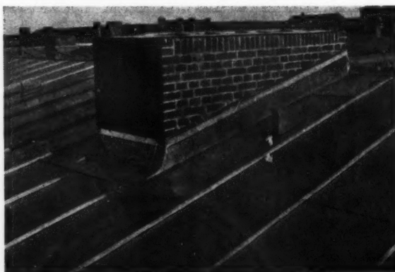
TOITURE EN ALUMINIUM (système à joints debout)
