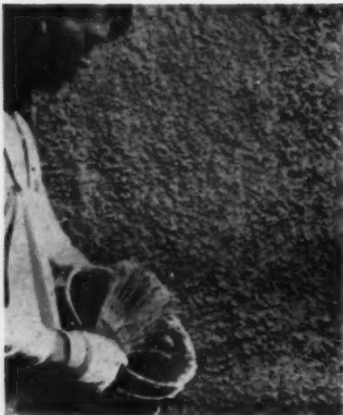
FIG. 9 ET 10. — ENDUIT TYROLIEN 1° Pose à la truelle d'une mince couche de finissage. 2° Projection du mortier à la brosse dure.
