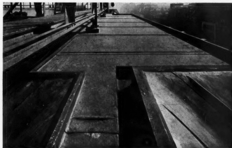
TERRASSE DE LA BRASSERIE « LA MAXÉVILLE », PLOMB DE 3 mm. Documents du Centre d'Information du Plomb Ouvré
