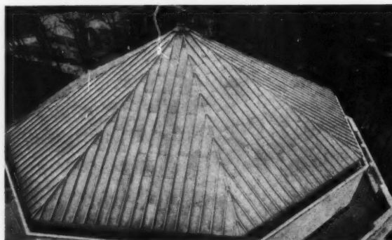
TOITURE EN ALUMINIUM (système à tasseaux)
