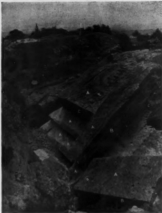
PLANS PRINCIPAUX D'UNE CARRIÈRE Document Derivillé A: Lit ou passe — B: Délit ou contrepassé — C: Délit (« bois debout »)
