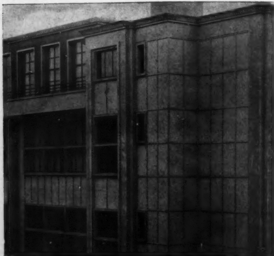
FIG. 6. — REVÊTEMENT EN MOSAÏQUE DE GRÈS CÉRAME (ÉCOLE A PARIS, ARCH. BOILEAU)
