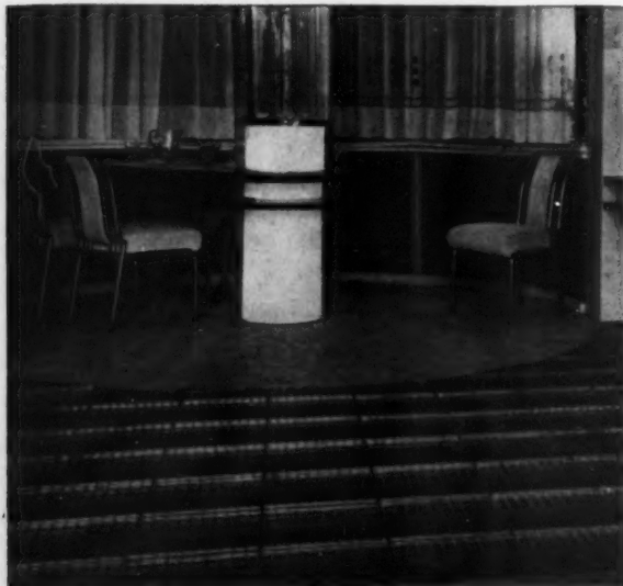
REVÊTEMENT DE SOL EN DALLES DE VERRE QUADRILLÉES (PIERRE PETIT, DÉCORATEUR) Photo Jean Colas
