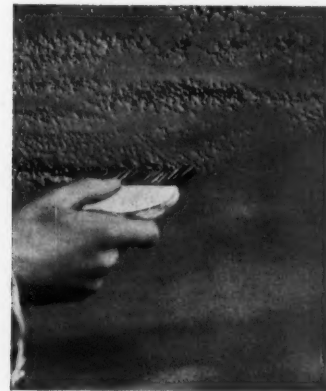
FIG. 25 et 26. — Texture obtenue par pressions avec une brosse dure.
