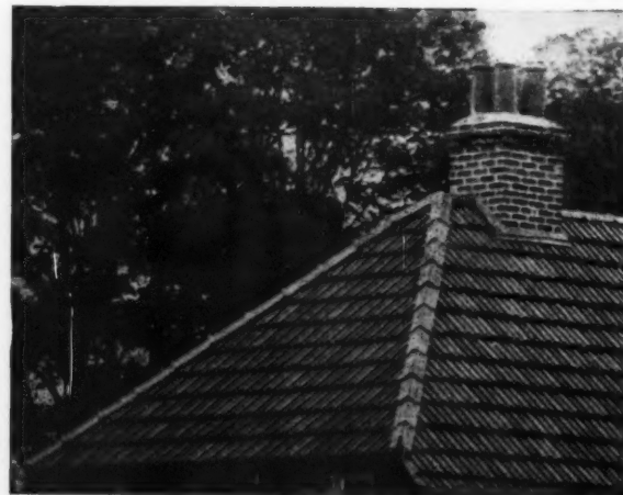
COUVERTURE EN TUILES MÉCANIQUES
