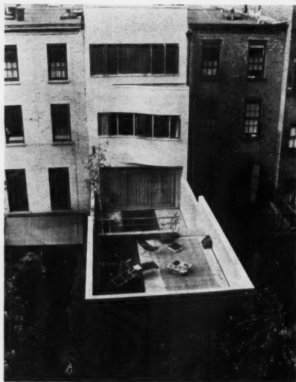
FAÇADE SUR COUR
