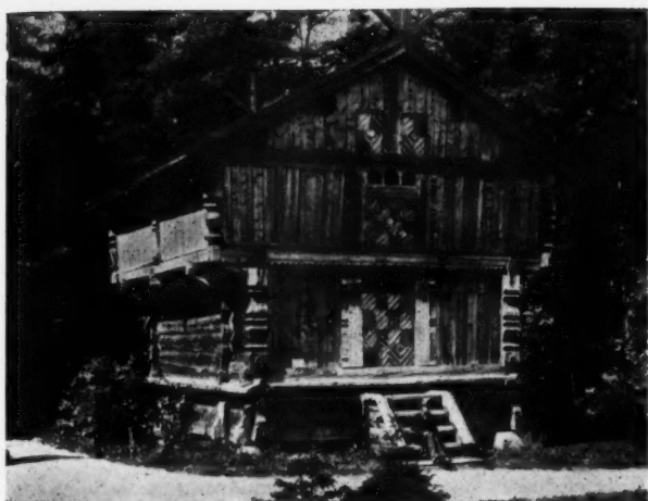
FIG. 3. — MAISON NORVÉGIENNE ANCIENNE. CONSTRUCTION MASSIVE EN TRONCS OVALISÉS ET, EN PARTIE, PAR PANNEAUX ET OSSATURE
