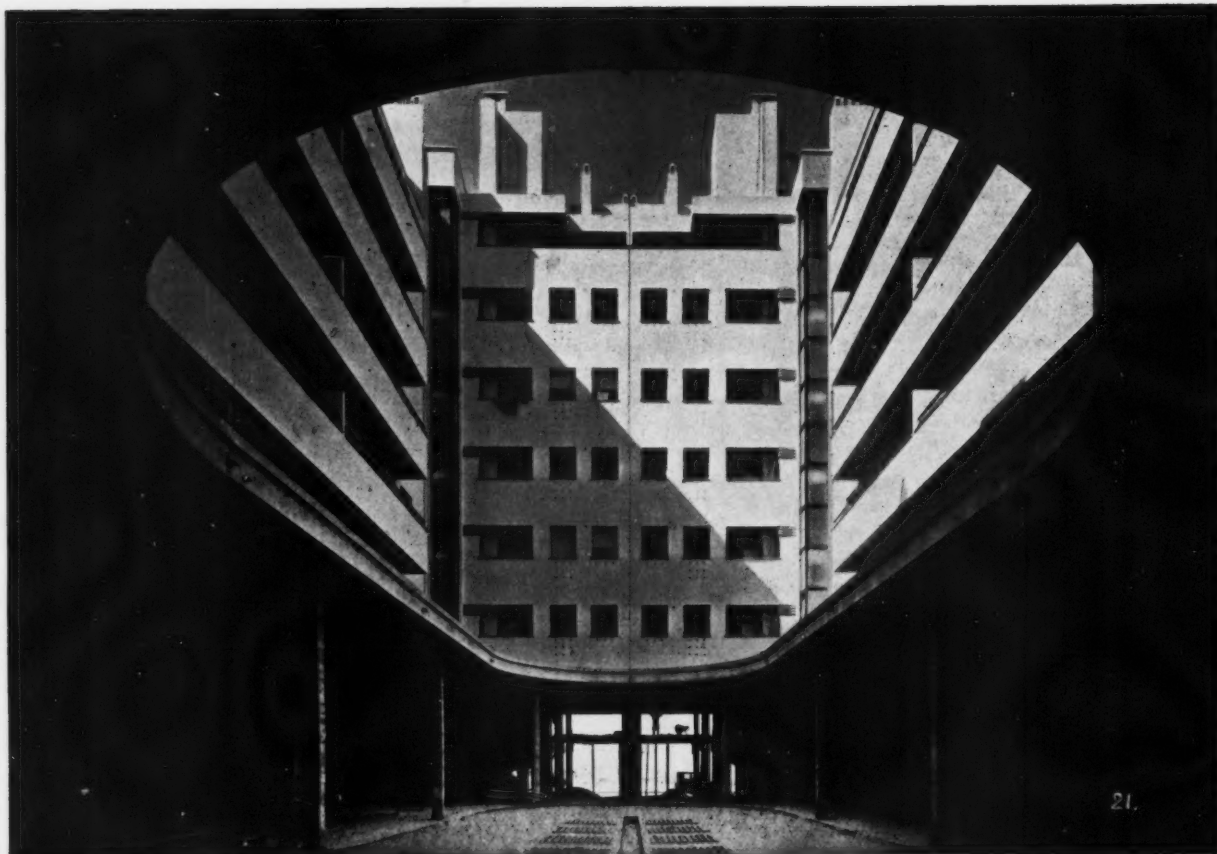
GRUPE D'IMMEUBLES, RUE SAVORGNAN DE BRAZZA. LA COUR
