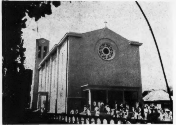
EGLISE DE TROIS-RIVIÈRES
