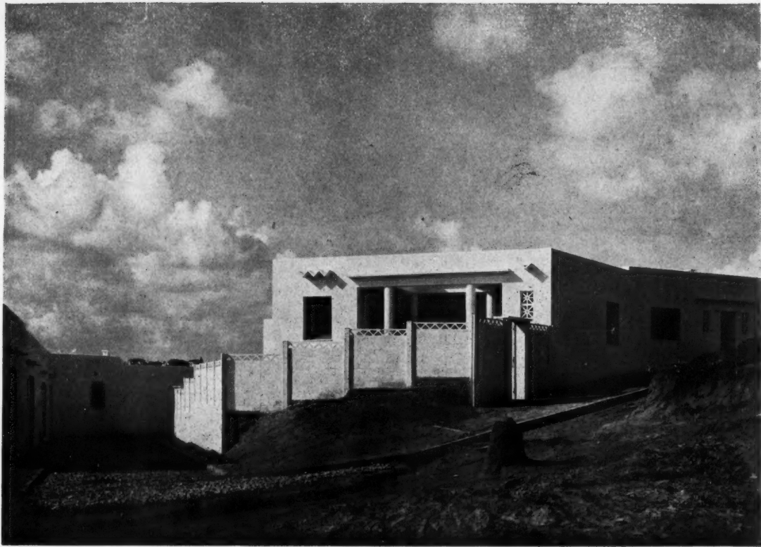
ALGER: LOTISSEMENT INDIGÈNE DU CLOS SALEMBIER ARCHITECTES: ALBERT SEILLER ET MARCEL LATHUILLIÈRE
