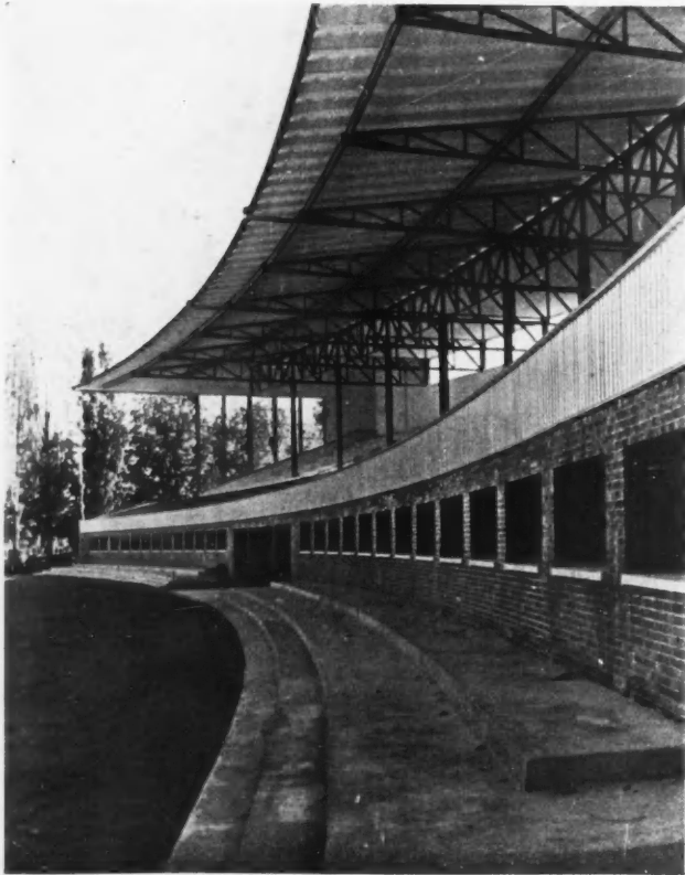
SACHLICHKEIT ET ROMANTISME AU CHAMP DE SPORT OLYMPIQUE DE BERLIN TRIBUNE DU STADE HIPPIQUE Belle construction soudée.
