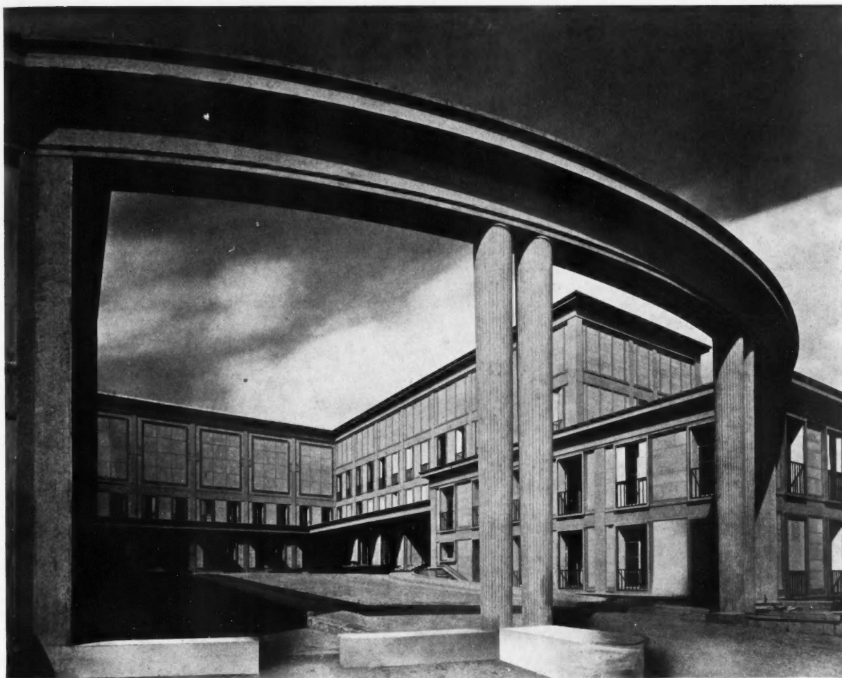
MOBILIER NATIONAL: DÉTAIL DE L'ENTRÉE AVANT LA POSE DES GRILLES
