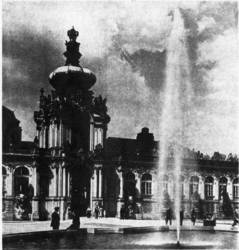
DRESDE. LE « ZWINGER » PORTE DE LA COURONNE. ARCHITECTE: DANIEL POEPELMANN, VERS 1715.
