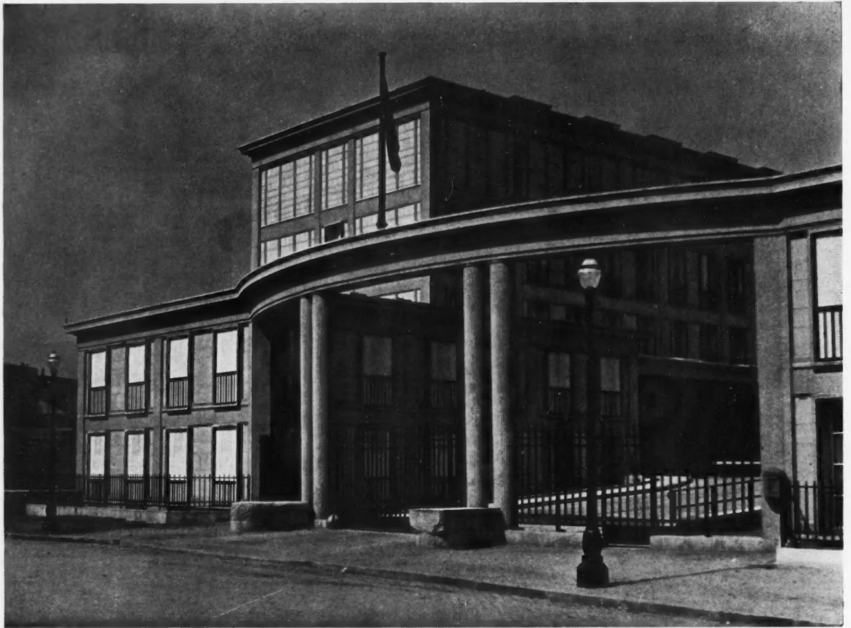
MOBILIER NATIONAL: ENTRÉE PRINCIPALE
