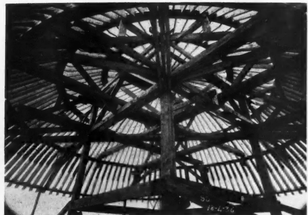
VUE DE LA CHARPENTE DE COFFRAGE D'UNE DES COUPÔLES DE L'ÉGLISE SAINTE-ODILE
