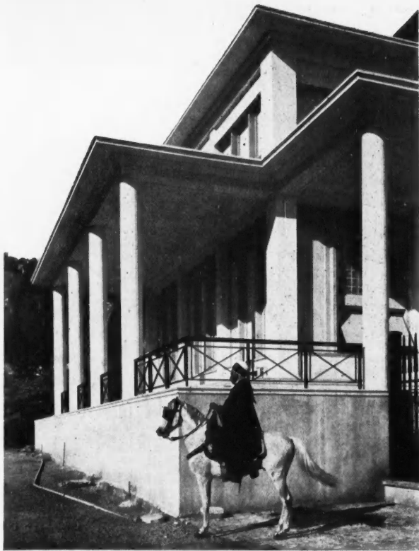
PALAIS DU GOUVERNEMENT GÉNÉRAL. GUIAUCHAIN, ARCH.
