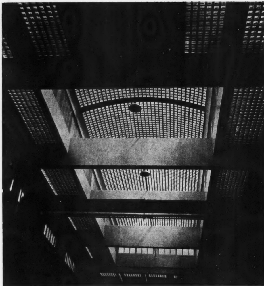
COUVERTURE EN BÉTON TRANSLUCIDE DU HALL DES ESSAIS
