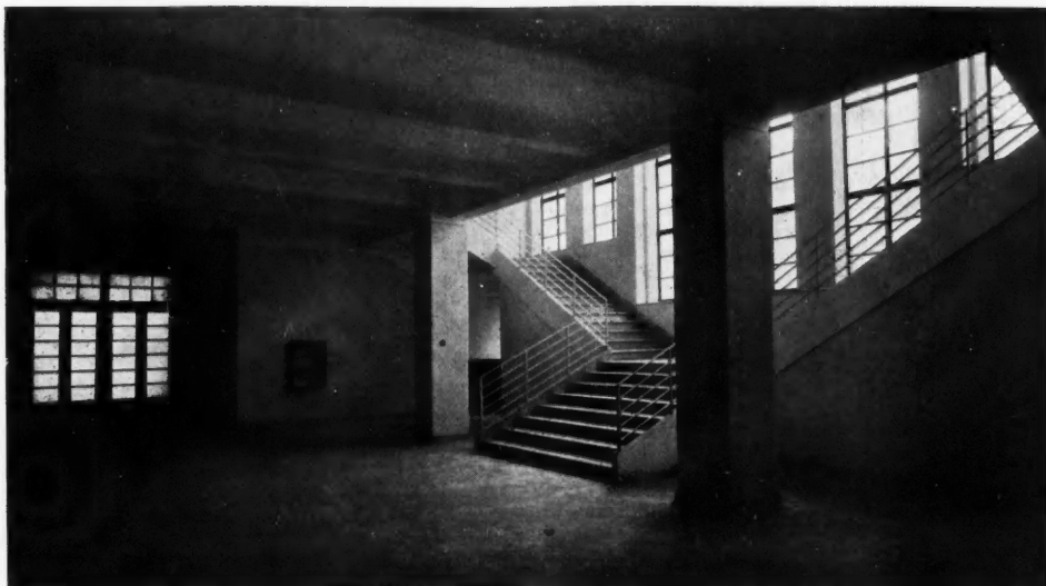
ESCALIER PRINCIPAL DE L'INSTITUT D'ANATOMIE
