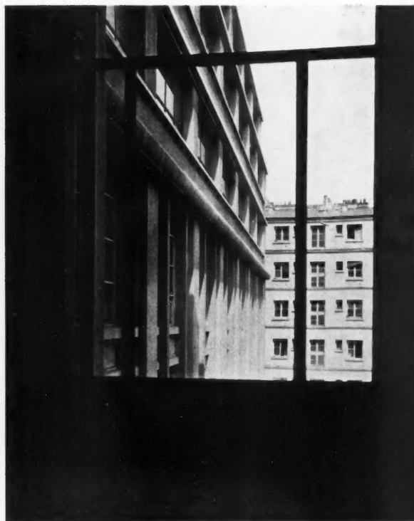
FAÇADE SUR COUR VUE DU BATIMENT DE L'AVENUE WAGRAM
