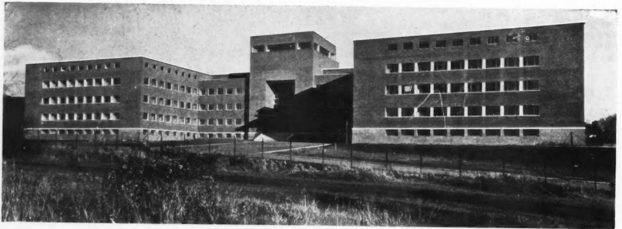
FAÇADES SUD DU BATIMENT DES SCIENCES NATURELLES
