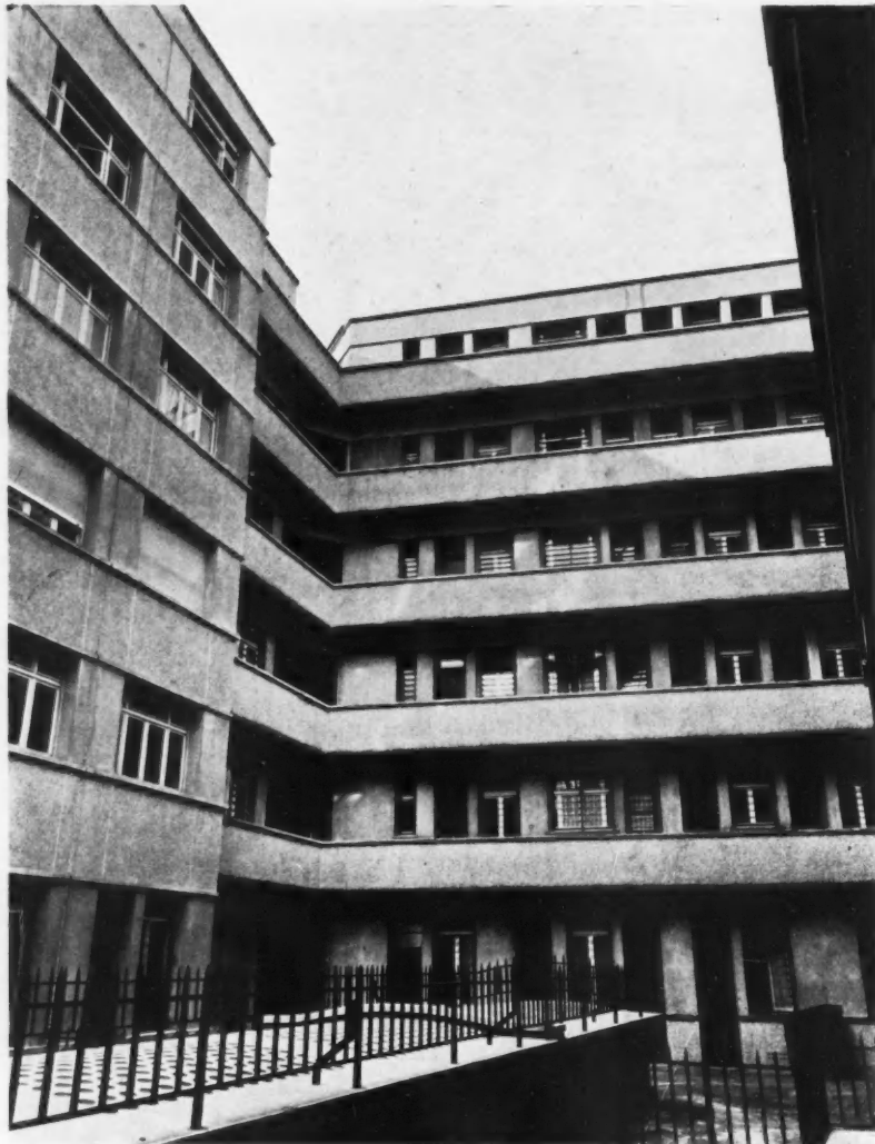
FAÇADES SUR COUR
