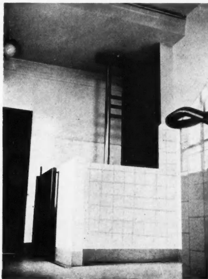
LE SOMMET DU MAT DE DESCENTE
