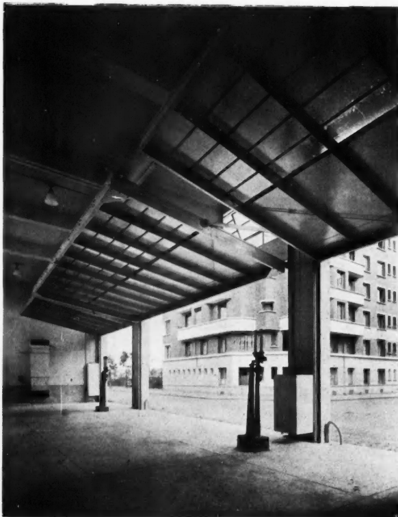
VUE INTÉRIEURE DU HALL DES POMPES
