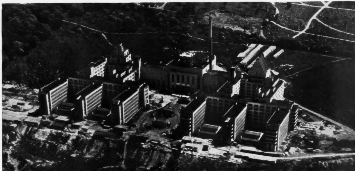
VUE GÉNÉRALE DE L'UNIVERSITÉ DE MONTRÉAL EN COURS DE CONSTRUCTION
