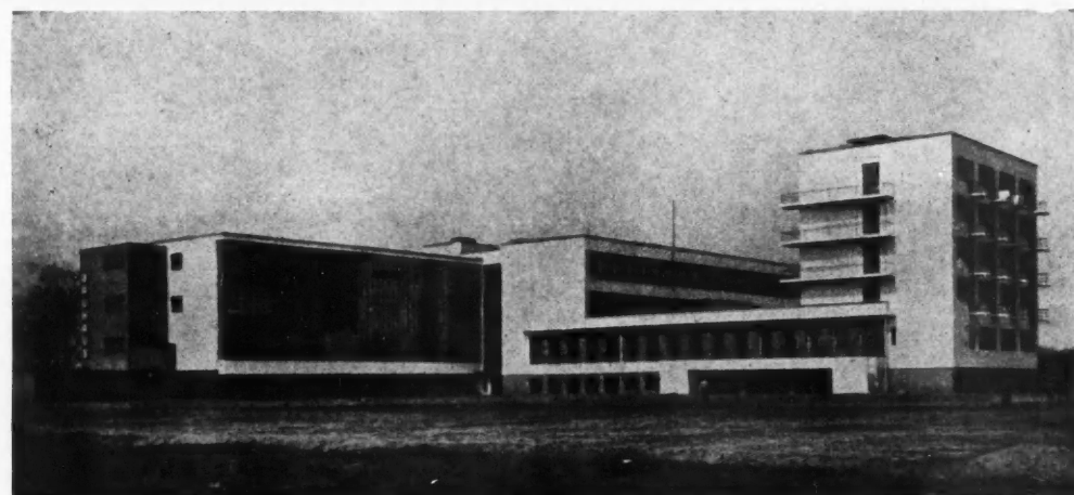
ALLEMAGNE Le Bauhaus à Dessau. A. Gropius, architecte. Ecole d'architecture et des Arts et Métiers. Au premier plan, à droite, le bloc des habitations et ateliers des professeurs.
