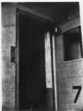
Fig. 19. — GRILLE ARTICULÉE POUR MONTE-CHARGE
