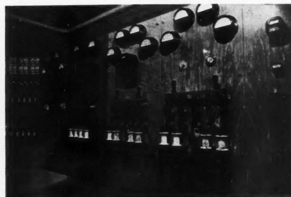
FIG. 4. TABLEAU COMPTAGE ET SECOURS
