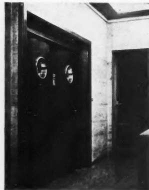
Fig. 20. — PORTES PALIÈRES EN TOLE BRONZÉE (LAPRADE ET BAZIN, ARCHITECTES)
