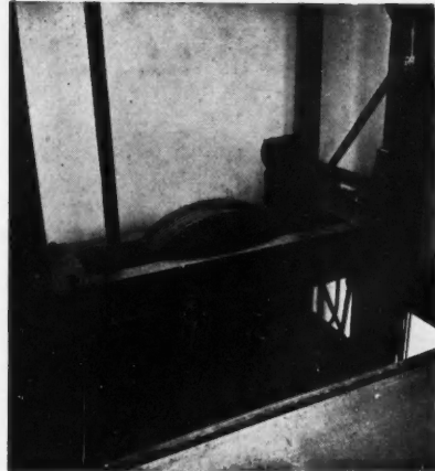
Fig. 14. — POULIE DE MOUFFLAGE DE LA CABINE D'UN MONTE-CHARGE (2 T. 5 à 0,5 m/s).
