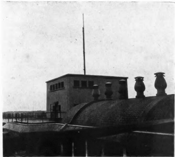
Fig. 8. — Vue extérieure de la machinerie.
