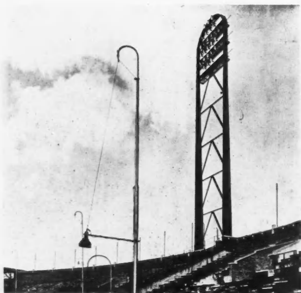
PYLONES SUPPORTANT LES PROJECTEURS
