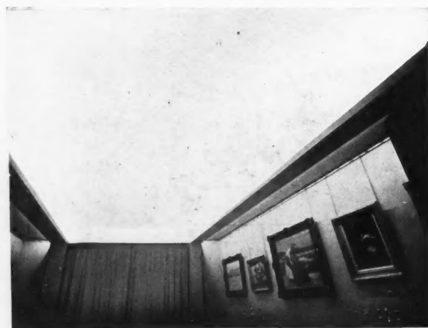
FIG. 13. ÉCLAIRAGE D'UNE SALLE D'EXPOSITION. DUPRÉ-LAFON, ARCHITECTE. A. SALOMON, INGÉNIEUR-ECLAIRAGISTE Éclairage direct sur les tableaux. Éclairage indirect par le plafond. Doc. Mors-Perflecta
