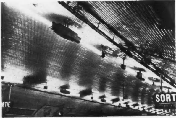
MÉTROPOLITAIN DE PARIS: STATION RICHELIEU-DROUOT Éclairage par tubes luminescents. Doc. Claude-Paz et Silva
