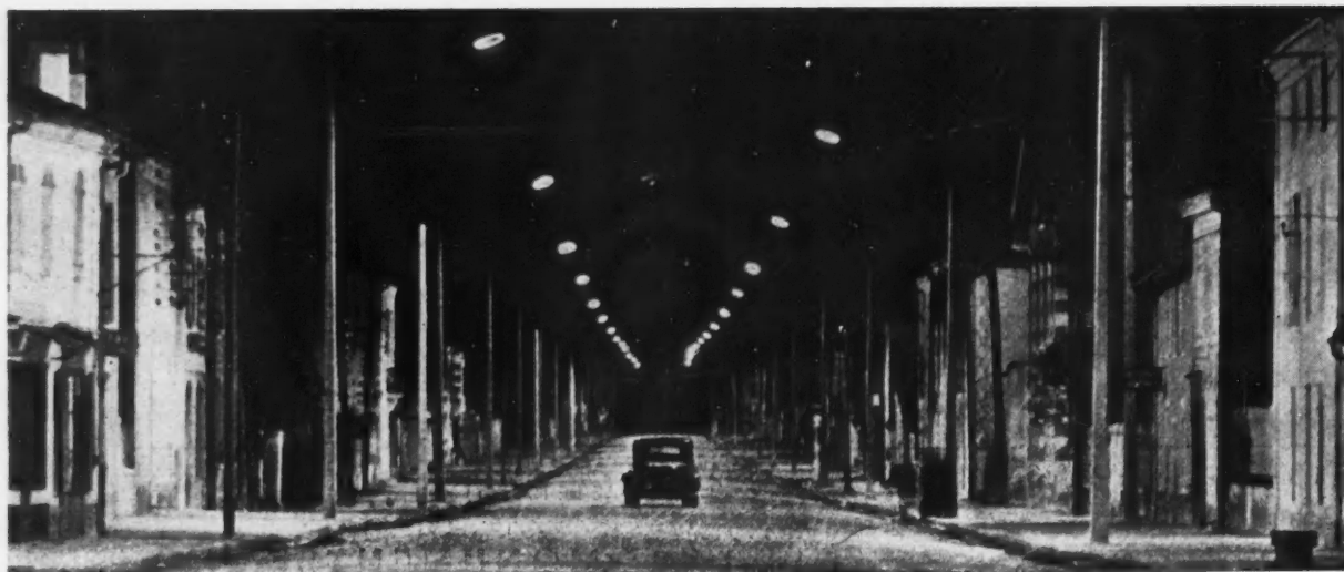
FIG. 1. ROUTE DE MONT-DE-MARSAN A BORDEAUX. Lampes de 100 w. au sodium, hauteur 9 m., disposition bilatérale en quinconce. Une lampe tous les 30 m. (largeur de la voie: 22 m.). (Document Philips)
