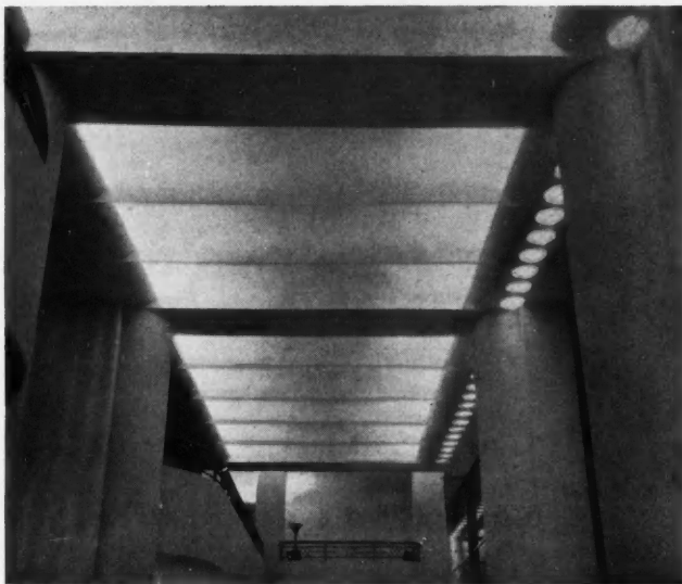
FIG. 16. GRANDS MAGASINS 39 projecteurs avec grilles anti-aveuglantes et lampes de 150 watts. Dans les corniches: 128 réflecteurs avec lampes de 75 watts. (Photo Boiron - Doc. Cie des Lampes)
