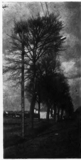
(Philips) Fig. 24. — Eclairage au sodium. Support en béton vibré.
