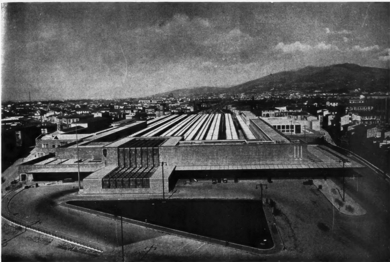
VUE D'ENSEMBLE DE LA NOUVELLE GARE DE FLORENCE, FACE A L'EGLISE SANTA-MARIA NOVELLA. ARCHITECTE: LE GROUPE TOSCAN
