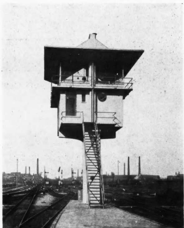
MAASTRICHS (PAYS-BAS). ARCHITECTE: VAN RAVENSTEYN
