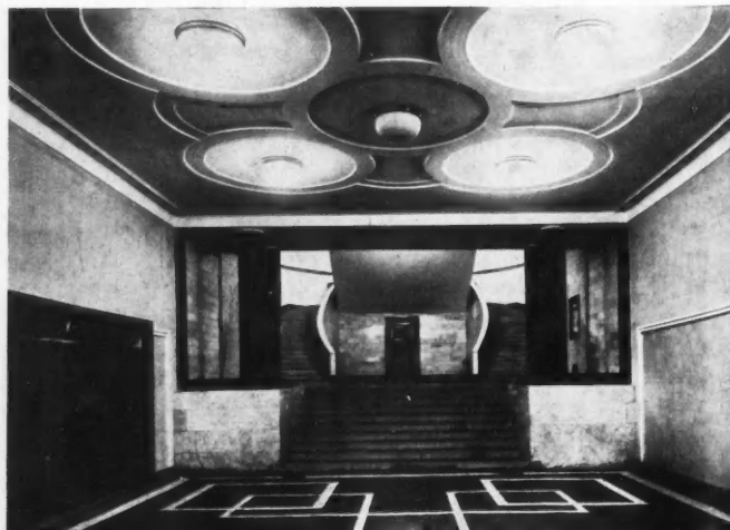
INTÉRIEUR DE LA STATION SQUARE DE CRIMÉE, œuvre des architectes Krutikov, Popov et Andriyevski. Piliers revêtus de marbre jaune; parois en pierre bleu-gris d'Oufaleisk. (Photo Zakharov)
