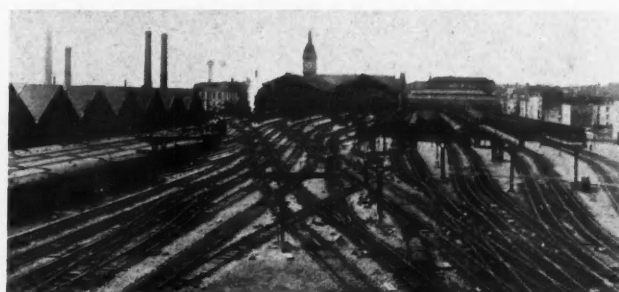
MÊME VUE, EN 1935, APRÈS LES TRAVAUX DE REMANIEMENT DES VOIES
