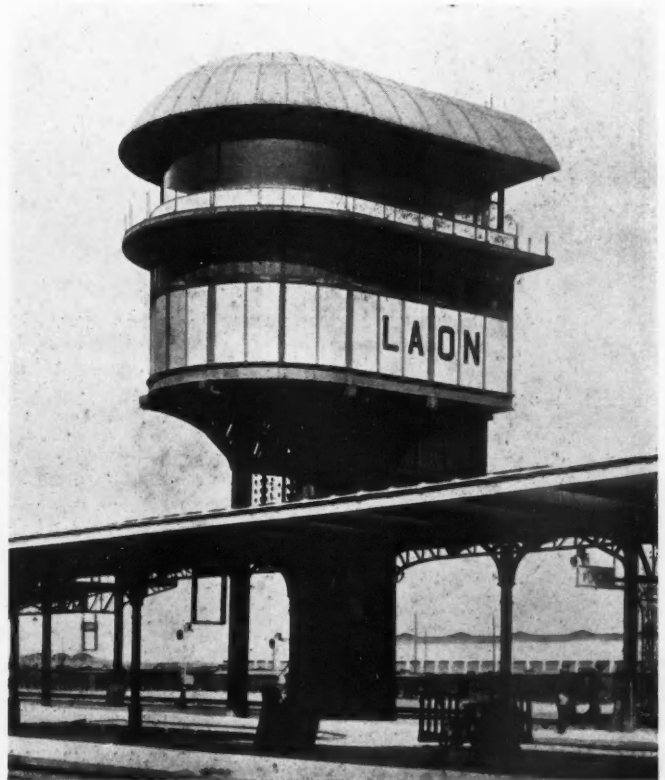
LAON: POSTE IMPORTANT, OSSATURE ACIER (RÉSEAU DU NORD)
