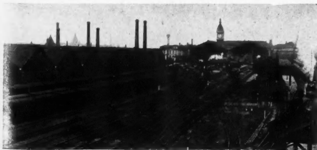
LA GARE EN 1932, AVANT LES TRAVAUX
