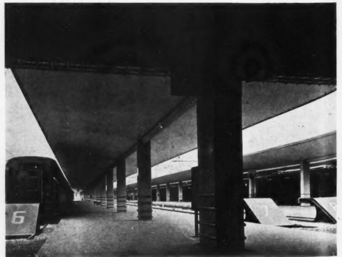
LES QUAIS. Les abris sont en ciment armé; piliers revêtus de marbre, 4 bandes de protection en bronze. La dalle est revêtue de mosaïque de verre blanc; gouttières en cuivre.
