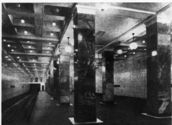
L'INTÉRIEUR DE LA STATION SOKOLNIKI, terminus de la première ligne du métro moscovite, est l'œuvre des architectes Bykova et Taranova. Parois recouvertes de dalles de vitrolite; pilastres revêtus de marbre bleu-gris; sol et escaliers en granit. (Photo Sokolovski)
