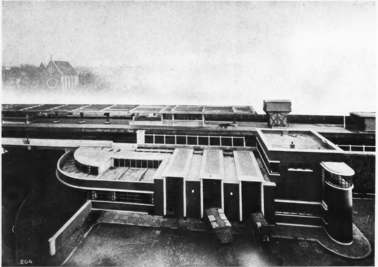
LA NOUVELLE GARE DE VANVES-MALAKOFF (ÉTAT): VUE D'ENSEMBLE
