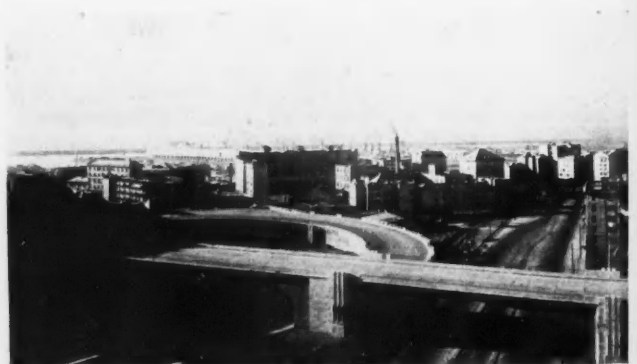
GARE ROUTIÈRE DE GÈNES. ARCHITECTES: G. CALZA-BINI
