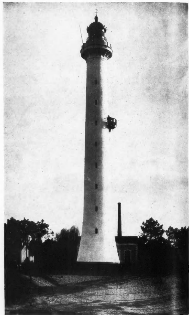
PHARE DE LA COUBRE. Phare récent, en béton armé fretté et banché; à mi-hauteur, un feu secondaire.
