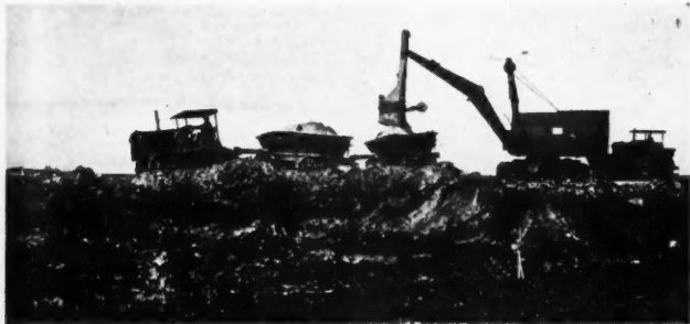
TERRASSEMENT AVEC PELLE ET ÉVACUATION PAR TRANSPORTEUR A CHENILLE
