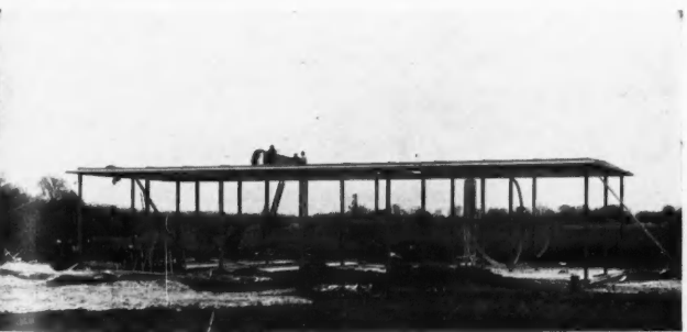
13 MARS 1936: Pose des éléments de toiture.
