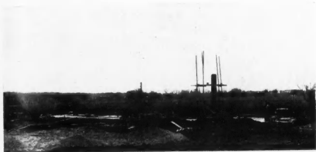
24 FEVRIER 1936: Construction de la dalle en B. A. et du conduit d'échappement des gaz brûlés.
