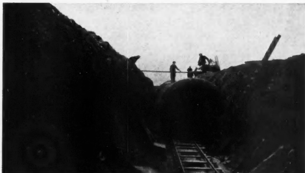
COLLECTEUR PRINCIPAL (ORLÉANS-BRÉCY). (Sté Gle d'Entreprise)
