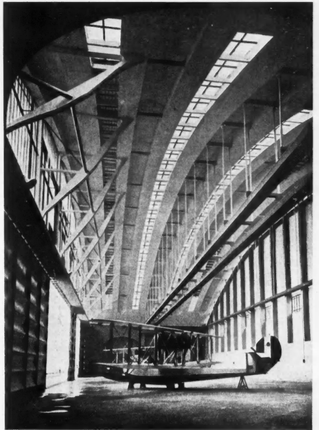
HANGAR EN BÉTON ARMÉ POUR HYDRAVIONS (ENRICO AMODIO ET GREGORIO NUNZIANTE, ingénieurs)
