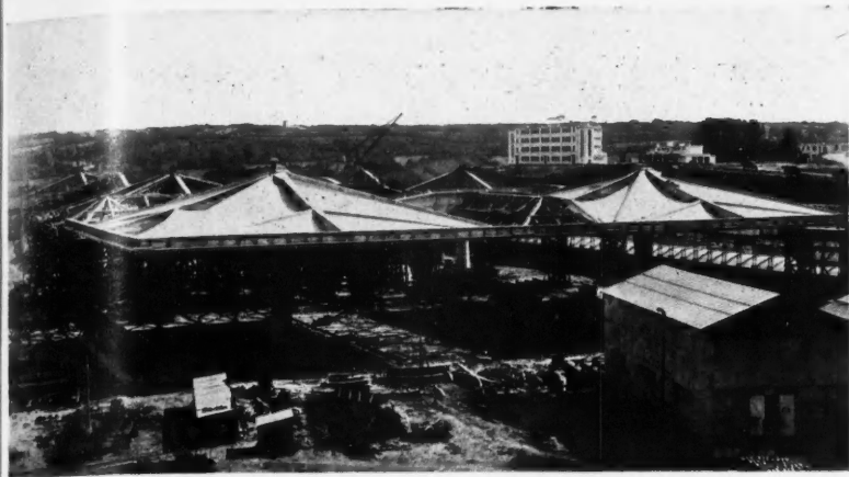
HANGAR EN BÉTON ARMÉ A 4 POINTS D'APPUI ET VOUTE EN PARABOLOIDES, EN CONSTRUCTION A LANVOEC-POULMIC. Entrepr. de trav. hydr. et Entr. Gén.
