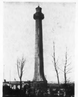
PHARE ENTIÈREMENT MÉTALLIQUE ÉDIFIÉ EN 1867
