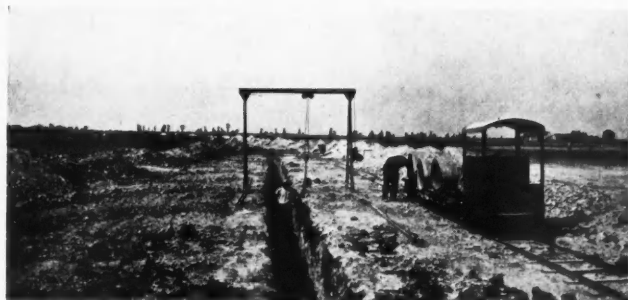
MISE EN PLACE DE DRAINS (ORLÉANS-BRÉCY)
