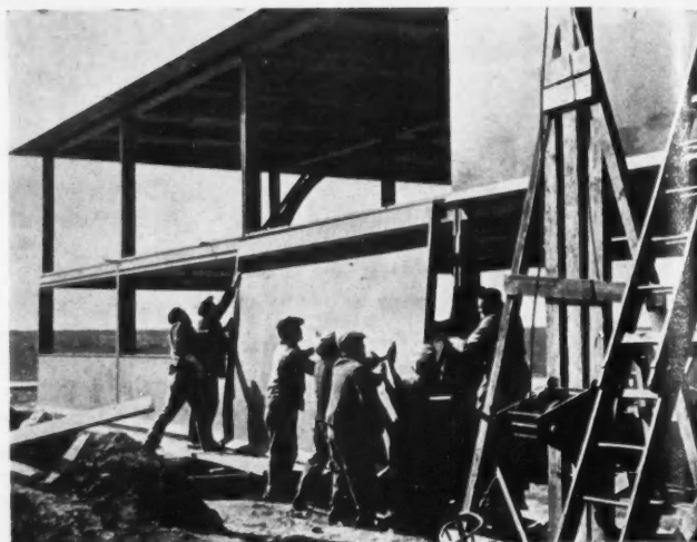
Pose d'un élément de façade.
