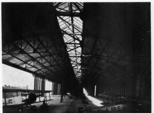
HANGAR A DOUBLE AUVENT A ST-ETIENNE-BOUTHÉON Sté Générale d'Entreprise, constr.
