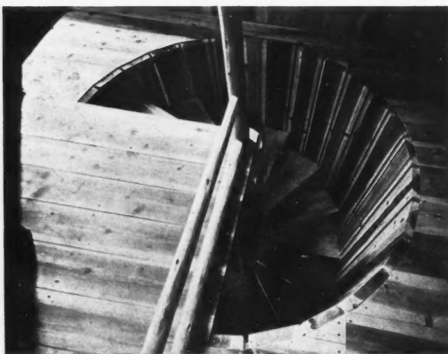
VUE DE L'ESCALIER D'ACCES A LA TRIBUNE
