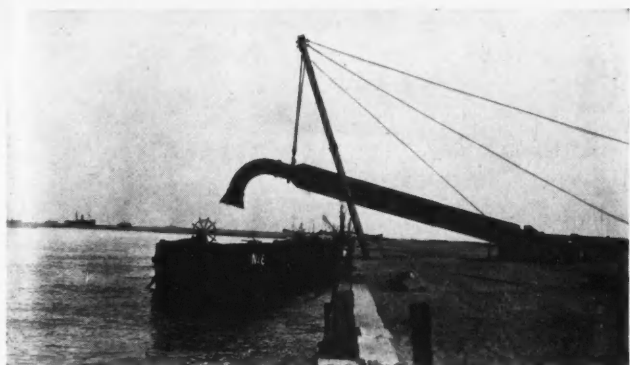
ASPIRATION ET REFOULEMENT DU SABLE
