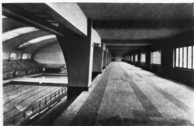
VUE DES COULOIRS D'ACCÈS AUX TRIBUNES. La largeur de ces couloirs permet d'y installer en certaines occasions des tribunes démontables prolongeant les tribunes permanentes.
