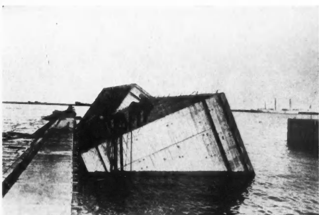
CONSTRUCTION D'UN MOLE
