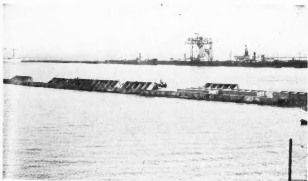
ASPECT D'UN QUAI EN CONSTRUCTION
