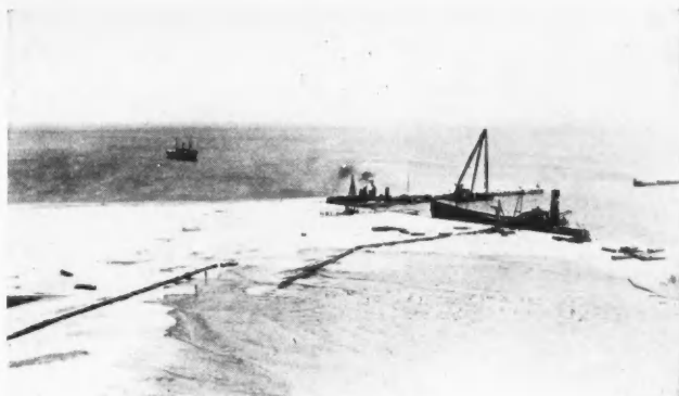
ASPIRATION ET REFOULEMENT DU SABLE
