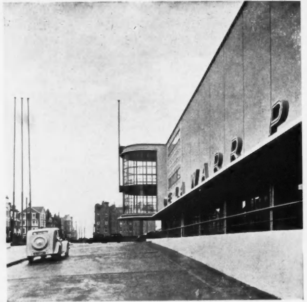
FAÇADE NORD. ESCALIER EN PORTE-A-FAUX
