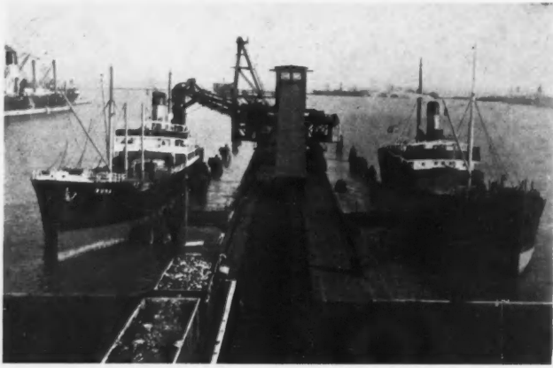
TAPIS ROULANT (650 tonnes/heure de charbon)
