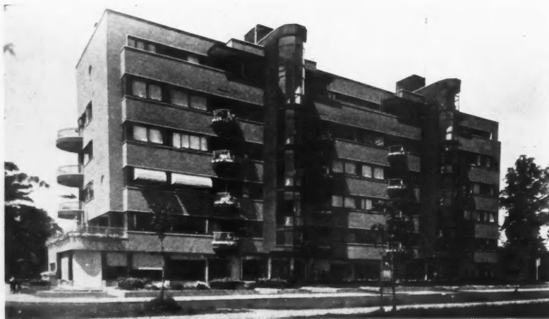
FAÇADE PRINCIPALE (NORD-EST)
