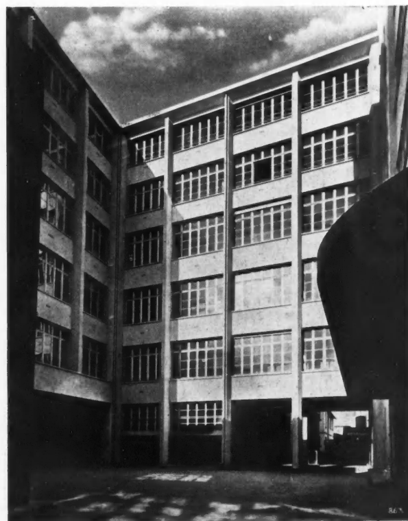
FAÇADE SUR COUR CENTRALE
