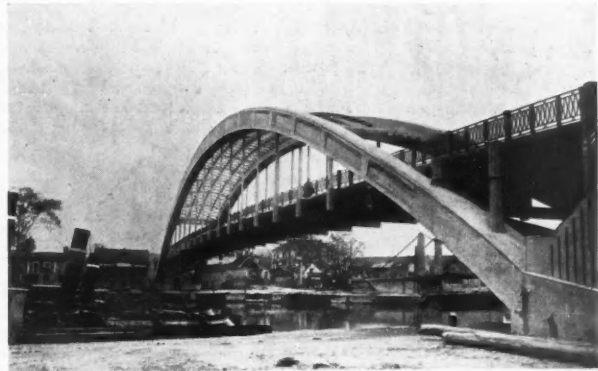
PONT DE CONFLANS-FIN-D'OISE Bibl.: Génie Civil - 1er Févr. 1930.
