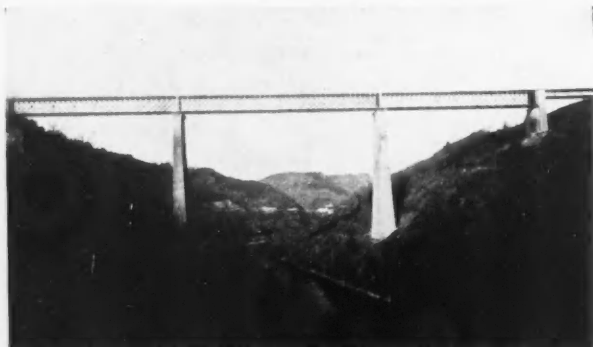
VIADUC DE FADES. POUTRE DROITE A TREILLIS MULTIPLE Travées de 116 + 144 + 116 m. Piles de granit de 93 m. Fondations de 45 m. (1907)
