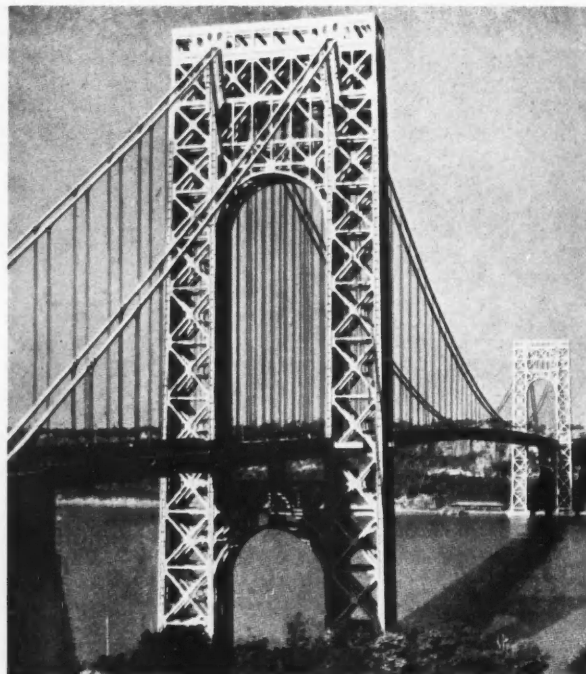
Doc. Ossature Métallique
