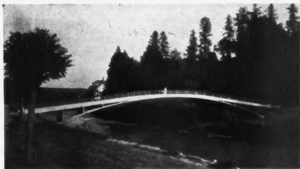
Doc. Maillart, Genève PASSERELLE SUR LA TOSS (WÜLFINGEN). Portée: 38 mètres. Epaisseur de l'arc à la clef: 14 cm. Bibl.: Schweizerische Bauzeitung, 1936, 11 avril.
