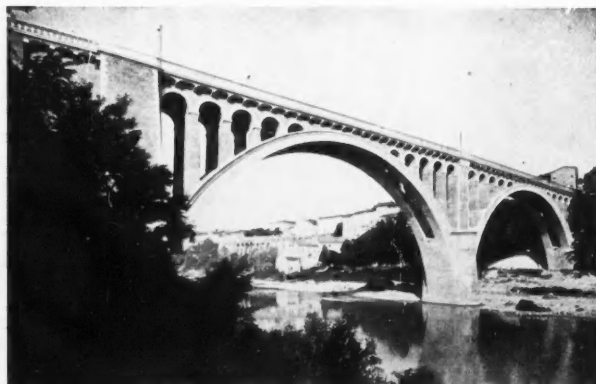
PONT EN MAÇONNERIE A RABASTENS (SUR LE TARN)
