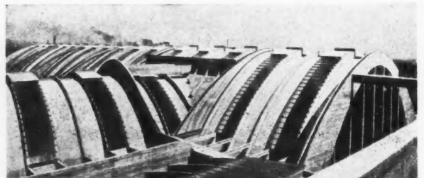
PÉNÉTRATION DES DEUX VOUTES, VUE PAR EN-DESSUS
