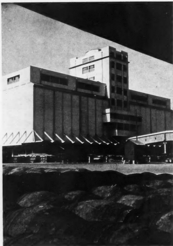
SILOS DU PORT D'ORAN
