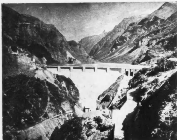
LE BARRAGE DU CHAMBON
