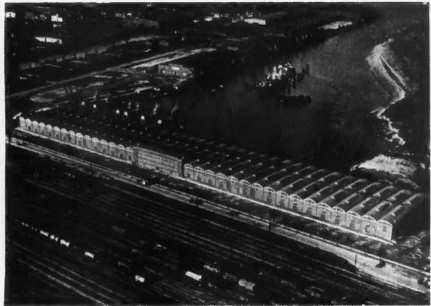
ENTREPOTS A HAMBOURG
