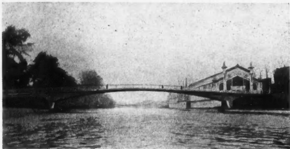
Doc. Hennebique PASSERELLE SUR L'OURTHE, A LIEGE (1904). Un des plus anciens ponts en béton armé. Portée: 12,5 + 55 + 12,5. Epaisseur à la clef: 35 cm.
