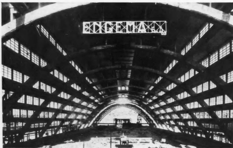
VUE PENDANT LA CONSTRUCTION
