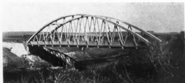
PONT SUR L'OUM-ER-REBIA (SIDI-AISSA). Toutes les armatures des tirants et les suspentes de ce pont sont en acier à haute résistance AC. 54 et ont été mises en tension avant bétonnage. (Portée: 67 m.). Bibl.: « Travaux » n° 42.
