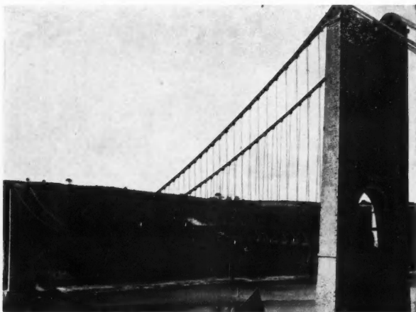
PONT DE TERENCEZ 37,50 + 272 + 37,50.
