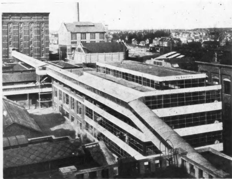
LES PASSERELLES DES CONVOYEURS
