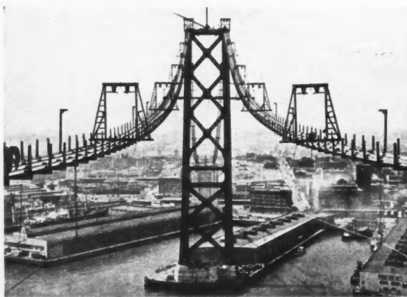
PONTS DE SAN-FRANCISCO A OAKLAND - FILAGE DES CABLES DE LA PREMIERE TRAVÉE SUSPENDUE: 357 + 707 + 353 m. PYLONE: 126 m.
