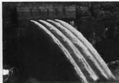
VANNE DE SORTIE
