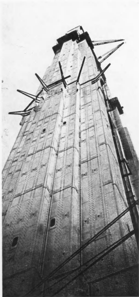
PONT DE LA PORTE D'OR, SAN-FRANCISCO, UN DES PYLONS, DE 210 M. DE HAUTEUR, EN CONSTRUCTION Bibliographie: Technique des Travaux, 1935, n° 11.
