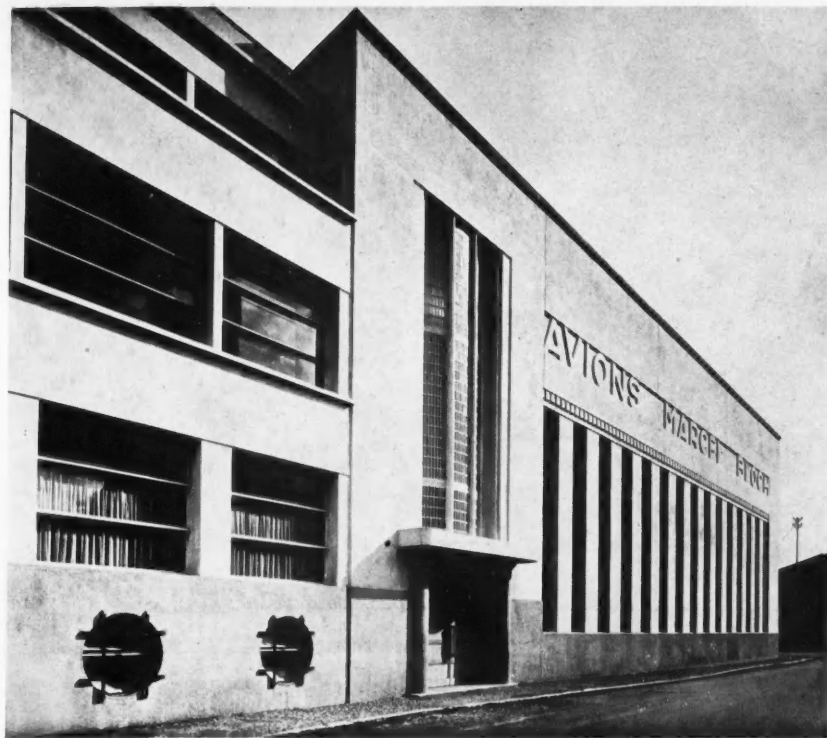
FAÇADE RUE DE L'INDUSTRIE. ENTRÉE DU PERSONNEL. A GAUCHE: BATIMENT DU PERSONNEL. A DROITE: HALL DE MONTAGE
