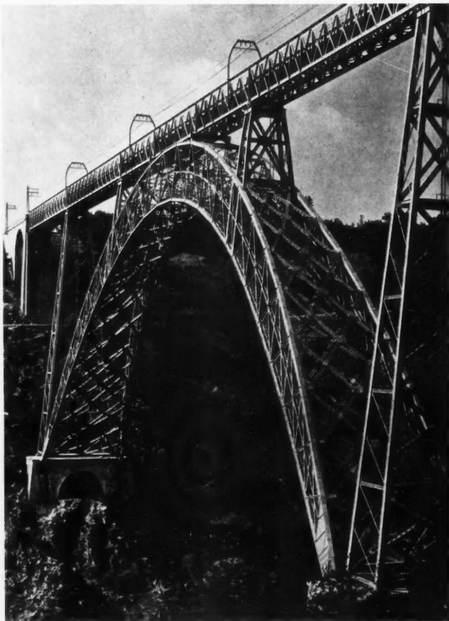
VIADUC DE GARABIT (EIFFEL)
