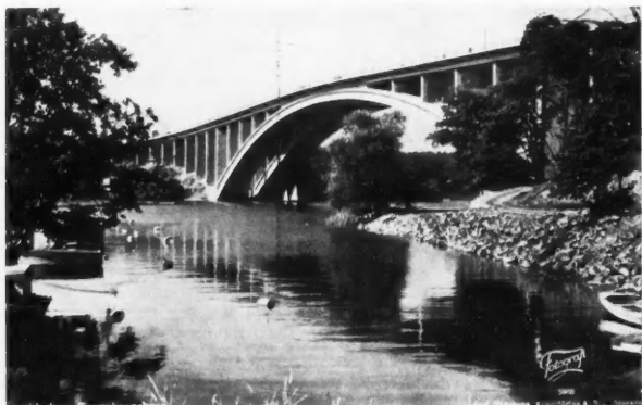
PONT DE TRANEBERG, A STOCKHOLM. Portée: 181 m. 2 arcs jumelés en béton armé, en forme de caisson à 3 compartiments. Largeur totale de chaque arc: 9 m. Hauteur: 3 à 5 m. La chaussée est portée par des poutrelles métalliques soudées reposant sur les piles en béton distantes de 13 m. Bibl.: Technique des Travaux 1936 - 8.
