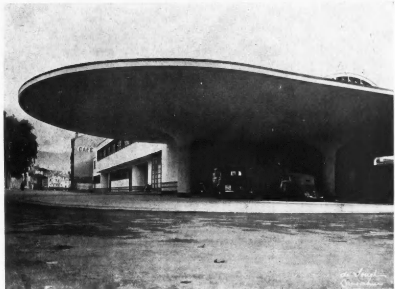
ABRI POUR VOITURES (ANGLE NORD-EST)
