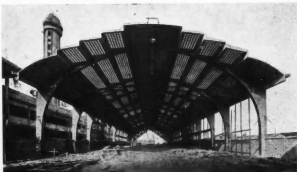
OSSATURE DE BÉTON ARMÉ, AVANT LES REMPLISSAGES (La dernière travée est encore sur cintre.)
