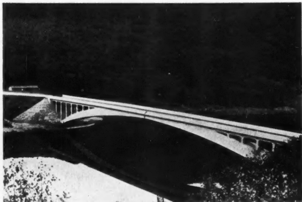
Doc. Rabut PONT DE LAIFOUR SUR LA MEUSE (1932). Portée: 97 m. Surbassement: 1/11°. Un 2° pont, identique, a été construit à proximité, à Anchamps. Cf: Travaux n° 24.
