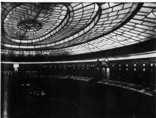
MAISON DES TRANSFORMATEURS ET COMMUTATEURS A L'USINE D'ÉLECTRICITÉ DE BUDAPEST
