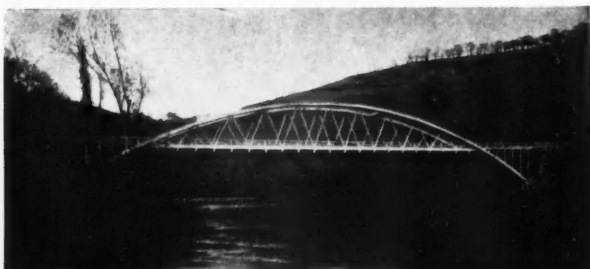
PONT SUR LE LOT, A PORT D'AGRÈS. Ouverture: 90 m. La disposition en V des suspentes assure une meilleure résistance aux charges roulantes et permet de diminuer la section des arcs.
