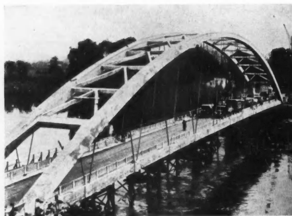
PONT DE CASTELMORON. Contreventement des arcs en forme de K, s'harmonisant avec la disposition des suspentes.
