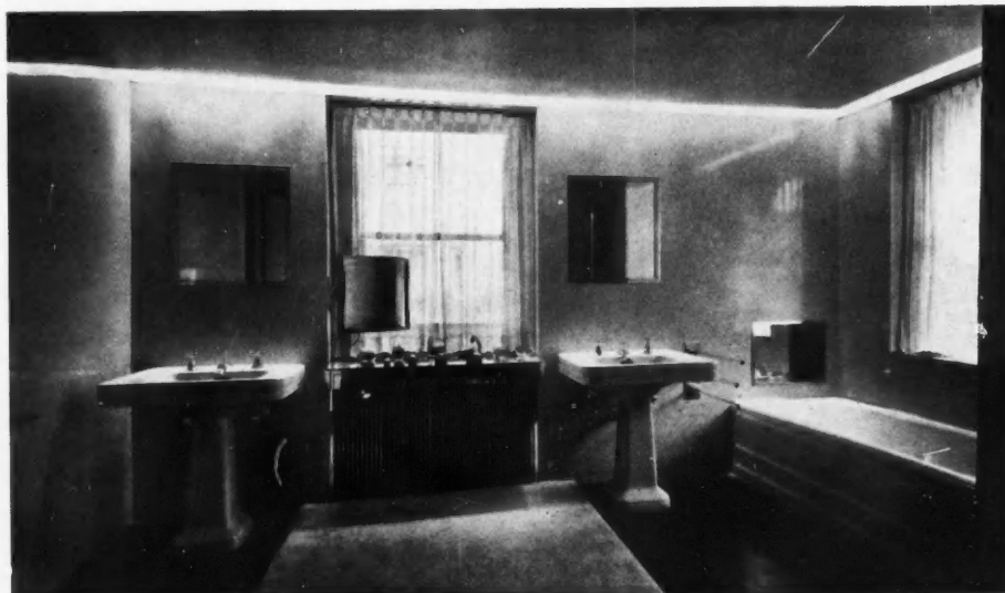
ÉCLAIRAGE INDIRECT PAR GORGE EN DÉFONCEMENT DANS LE PLAFOND PIERRE BARBE, ARCHITECTE
