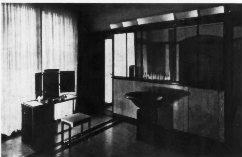
LAVABO EN MARBRE PORTOR, DALLAGE ET REVÊTEMENTS EN TRAVERTIN A. ET G. PERRET, ARCHITECTE
