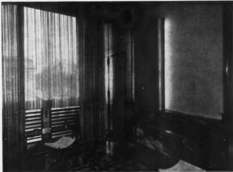
Sol et baignoire en marbre jaune de Sienne. Murs revêtus en glace argentee dépolie. L'alimentation de la baignoire se fait par ruissellement sur la paroi du fond. J. P. SABATOU, ARCHITECTE
