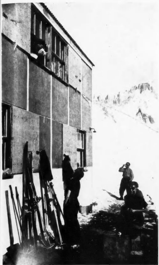
REFUGE D'ARGENTIÈRE. ANCIENNE FAÇADE SUD. Noter le peu de dépassement de l'ancienne toiture.
