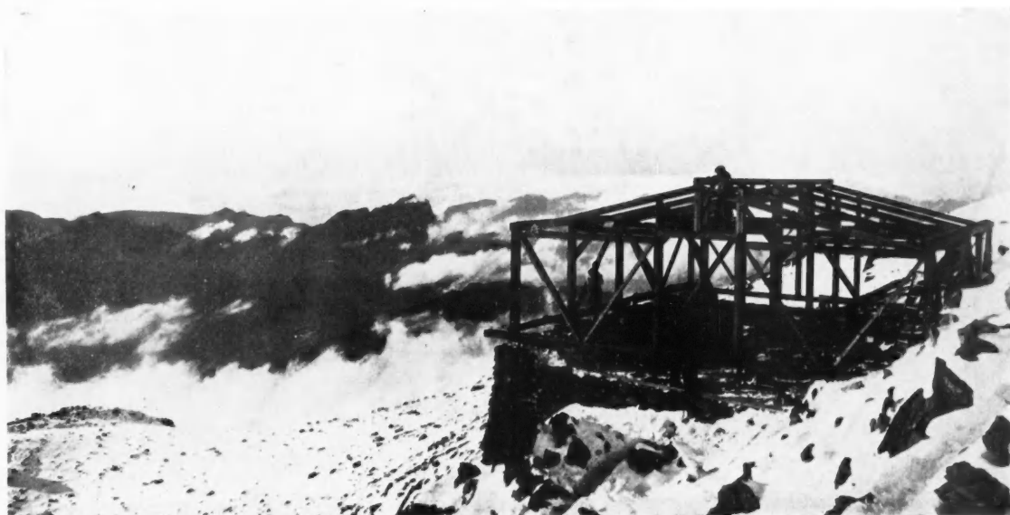
8 août 1934, 7 h. du soir. La charpente principale est dressée. Noter la hauteur considérable du remblai en pierres sèches. Le refuge complètement terminé, y compris l'électricité et la peinture, a été inauguré le 2 septembre. Durée totale des travaux sur place: 24 jours. — 2 ème étage du remblai: 4 m. environ. 1 er étage du remblai: 2 m. 50.
