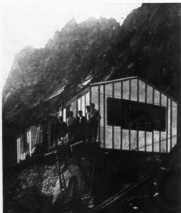
LE REFUGE DE LESCHAUX APRÈS AGRANDISSEMENT EN 1934. La partie ancienne forme la partie centrale et a été conservée telle quelle. Deux parties de 4,20 \times 5,50 ont été ajoutées à chaque extrémité. La partie de droite est construite sur chevalement de bois et le sous-sol forme cave. Les parois des adjonctions sont formées de complexes Isorel.
