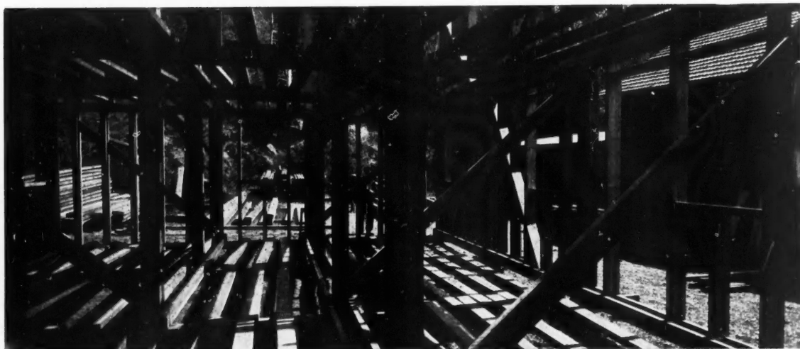
INTÉRIEUR DE LA CHARPENTE DU REFUGE D'ARGENTIÈRE. CONTREVENTEMENT LATÉRAL. Ce contreventement sera noyé par la suite dans les cloisons intérieures.
