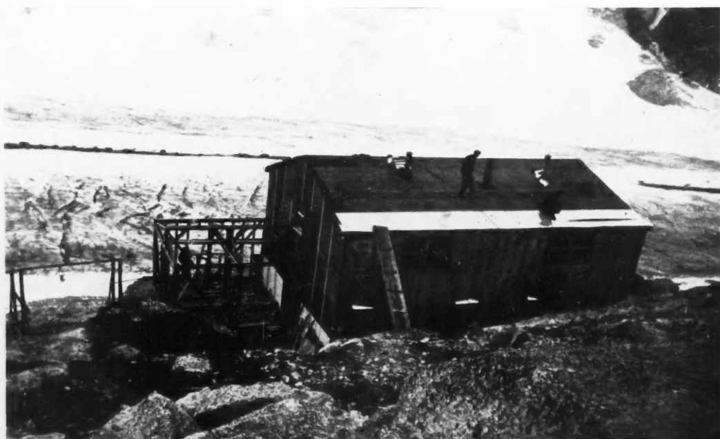
TRANSFORMATION DE LA TOITURE DU REFUGE D'ARGENTIERE. Sur le Ventex 7 plis on pose la tôle d'aluminium. Pendant qu'une équipe monte la charpente, une autre équipe s'occupe de poser la nouvelle couverture sur l'ancienne.
