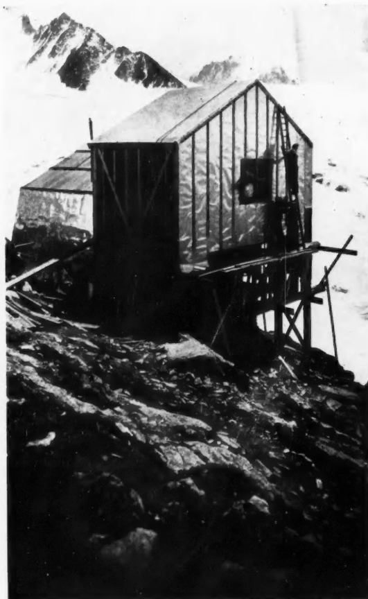
REFUGE ALBERT I er . POSE DU REVÊTEMENT EN TOLE D'ALUMINIUM ET DES CARREAUX. Noter le chevalement.
