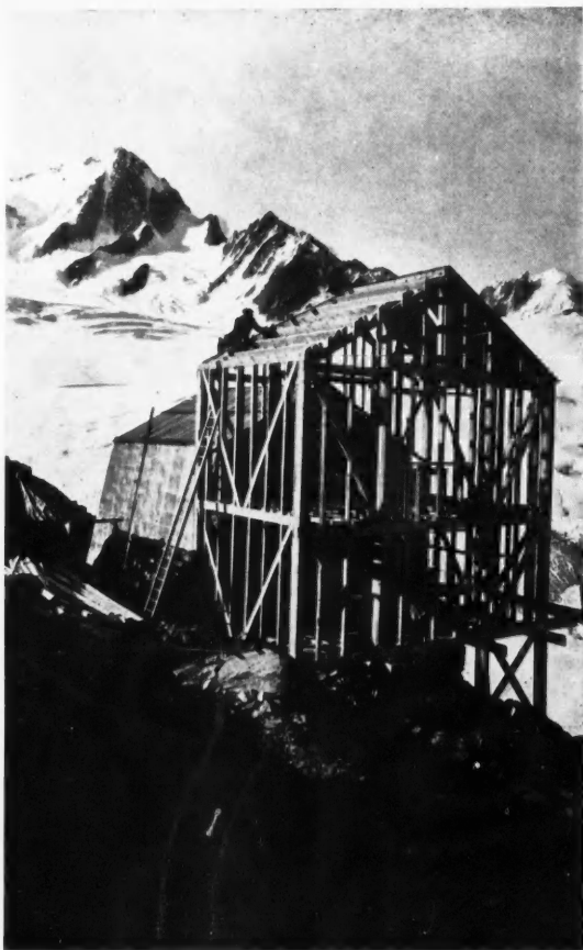
AGRANDISSEMENT DU REFUGE ALBERT I er . MONTAGE DE LA CHARPENTE
