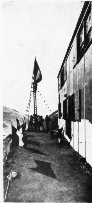
ANCIENNE FAÇADE EN EVERITE DU REFUGE D'ARGENTIERE
