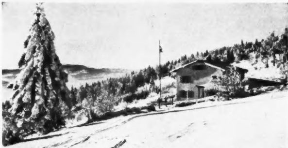
REFUGE DU MONT-MORON. ARCH.: BRAUNING, LEU, DURIG Cl. Baumeister
