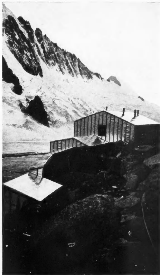
REFUGE D'ARGENTIÈRE. Altitude: 2.771 m. Modifications et agrandissement en 1936. Ce cliché montre la façon dont les divers bâtiments épousent une courbe de niveau pour s'adapter au terrain.
