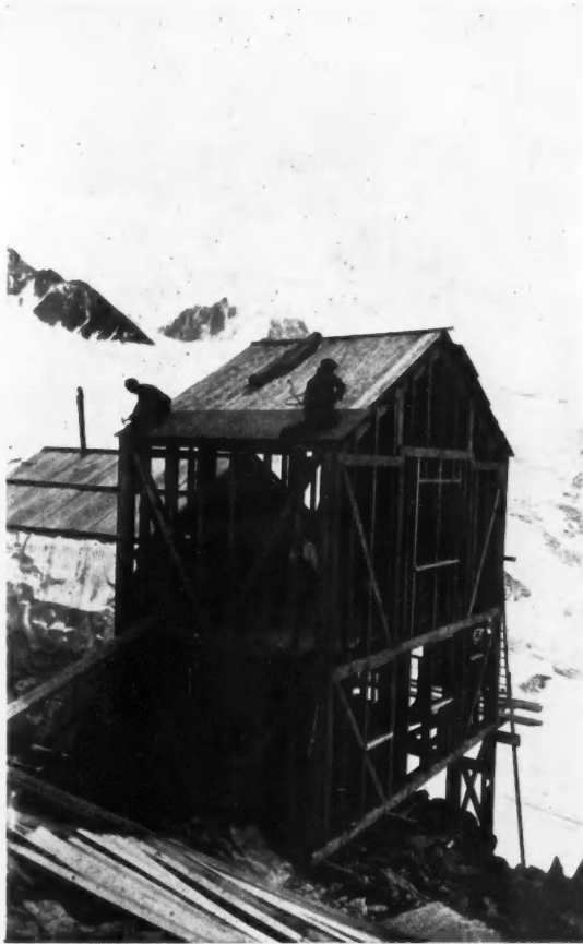
REFUGE ALBERT I er . POSE DE LA TOITURE. Feutre Ventex 7 plis. Noter le raccord arrière avec le rampant du toit ancien.
