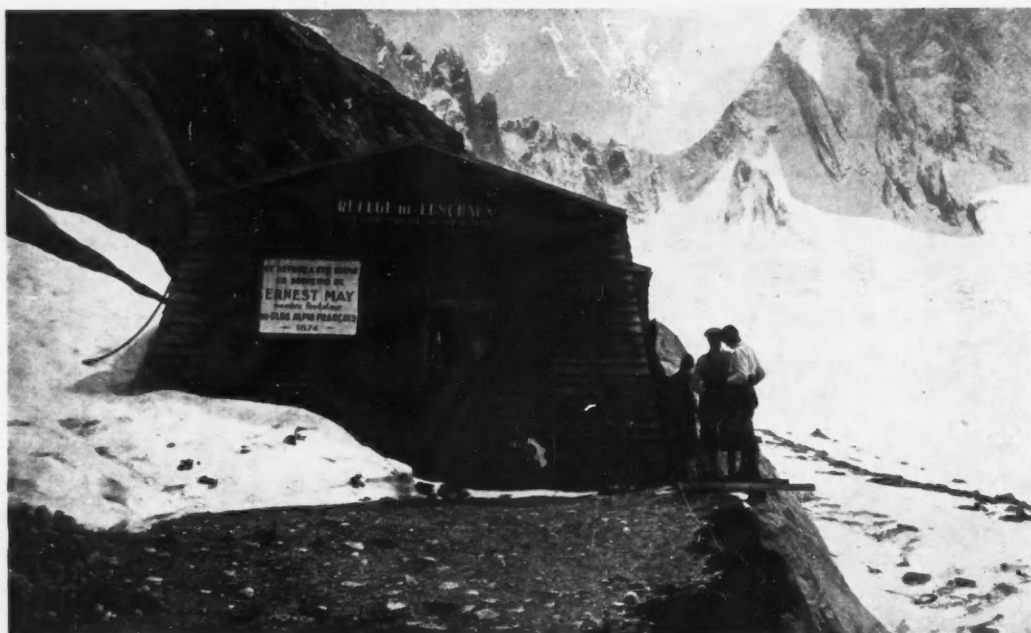
PREMIER REFUGE DE LESCHAUX, CONSTRUIT EN 1926, A 2.500 m. D'ALTITUDE, AU PIED DE LA FACE NORD DES GRANDES JORASSES. Ce refuge comportait une toiture métallique en ardoises de zinc et une double paroi de bois, la paroi extérieure étant formée de planches à clin.
