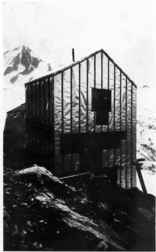
REFUGE ALBERT I er . FAÇADE OUEST. LE REFUGE TERMINÉ. Malgré le temps défavorable, le gros œuvre a été terminé en 10 jours.
