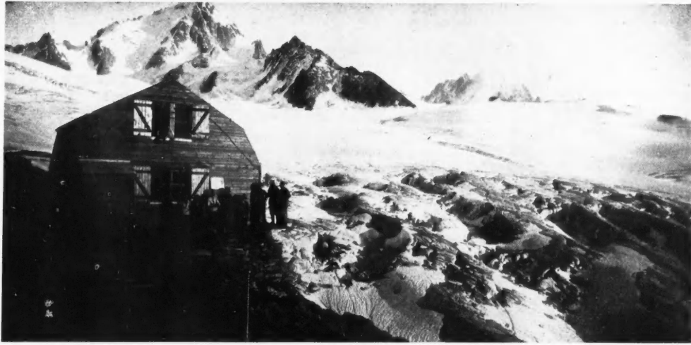
REFUGE ALBERT I er , ETAT PRIMITIF EN 1930, AVEC SON RECOUVREMENT EN PLANCHES A CLIN
