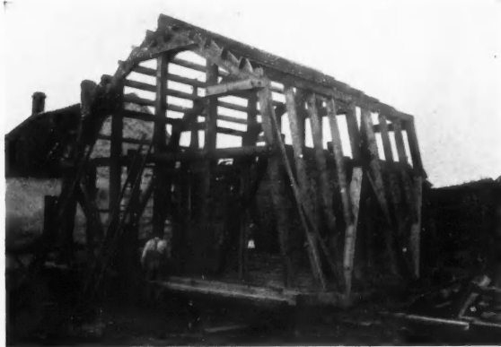
1929. MONTAGE AU CHANTIER DE LA CHARPENTE DE LA PREMIERE PARTIE DU REFUGE ALBERT I er . On remarquera la triangulation en tous sens des poteaux de ferme.
