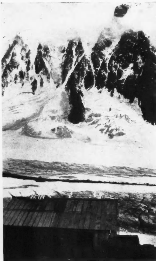
REFUGE D'ARGENTIERE. TRANSFORMATION DE LA TOITURE. Sur Everite ondulée on a placé des liteaux épousant le creux des ondulations, et par dessus on cloue un contreplaqué Océan colle B de 15 mm.
