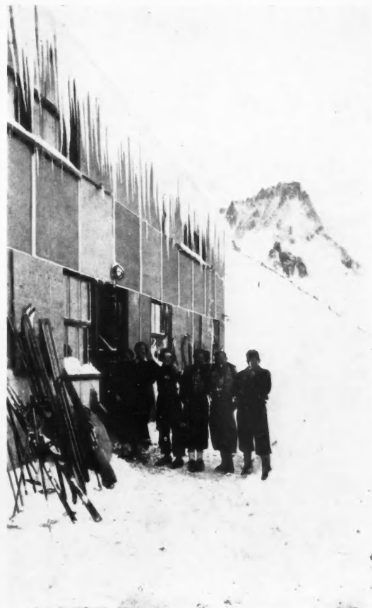
PAQUES 1934 AU REFUGE D'ARGENTIÈRE. Malgré le peu d'avancée de l'ancienne toiture, des stalactites de glace se forment et peuvent tomber sur la tête des skieurs.
