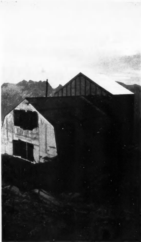
REFUGE ALBERT I er . Altitude: 2.800 m. La partie basse est constituée par le premier refuge construit en 1929. La partie haute représente l'agrandissement effectué en 1935. La partie basse était primitivement recouverte de planches à clin. Elle a été revêtue d'aluminium en 1933.
