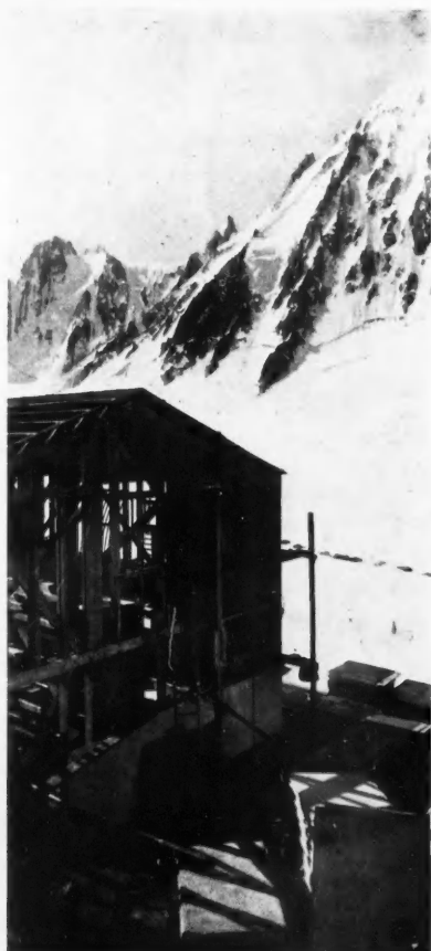
REFUGE D'ARGENTIÈRE. AOUT 1933. REVÊTEMENT DU PIGNON EST EN PLAQUES D'EVERITE
