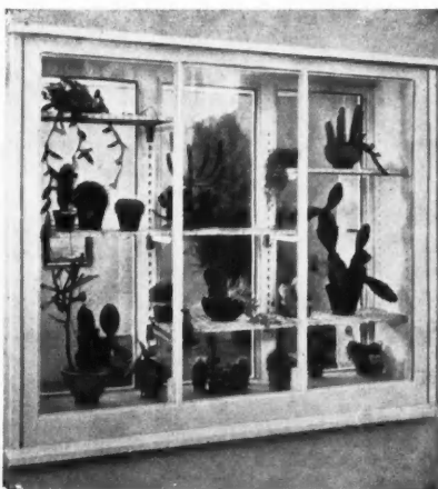
FENÊTRE A CHÂSSIS COULISSANTS HORIZONTALEMENT A L'AIDE DE CHARIOTS A BILLES. La fenêtre ouverte, les châssis disparaissent complètement dans un espace aménagé à cet effet dans le mur.
