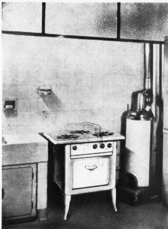
CUISINE COMPORTANT UNE CUISINIÈRE ET UNE CHAUDIÈRE À GAZ
