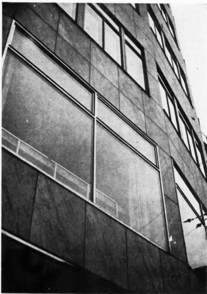
HUISSERIES INOXYDABLES SUR FAÇADE D'IMMEUBLE
