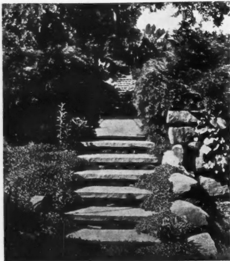
CHAQUE MARCHE EST FORMÉE D'UNE SEULE DALLE BRUTE Cl. Gardens and Gardening
