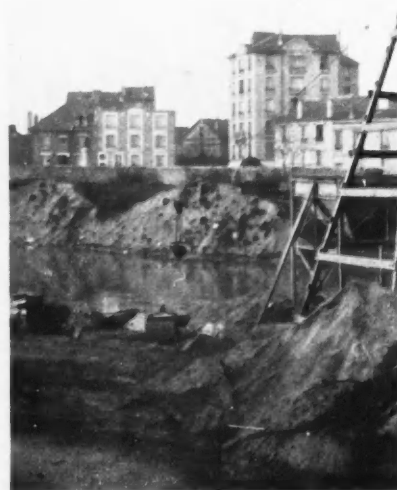
SQUARE JOFFRE: LE TERRAIN AVANT LES TRAVAUX DE REMBLAYAGE
