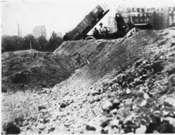
TRAVAUX AU SQUARE SEVERINE: REMBLAIS
