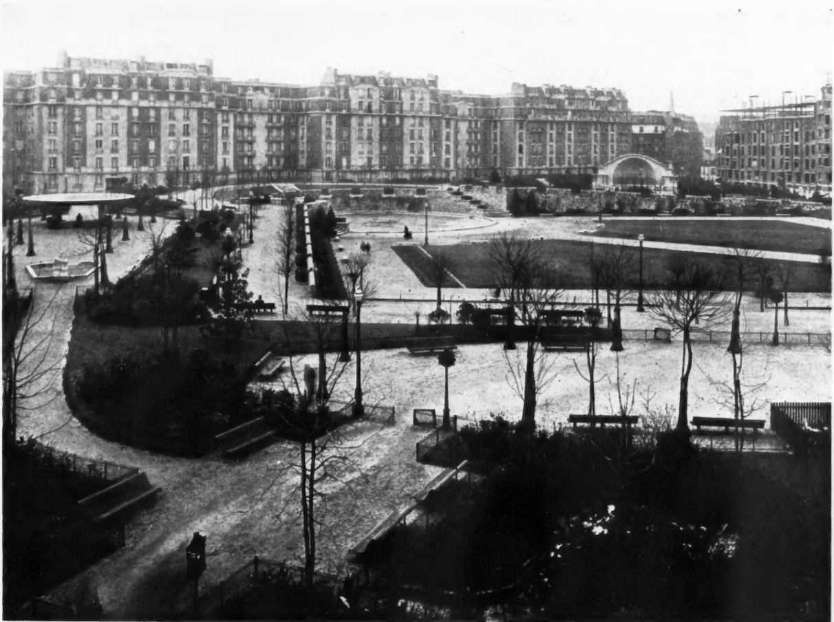
LE SQUARE SAINT-LAMBERT ARCHITECTE: G. SEBILLE
