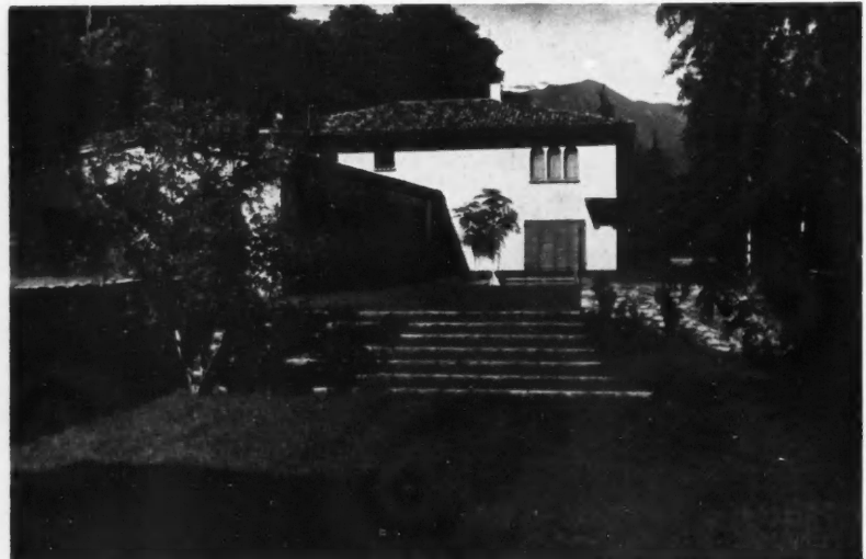
LAC MAJEUR (ASCONA) UN ESCALIER D'HERBE. Les contremarches sont formées d'un filet de pierres.
