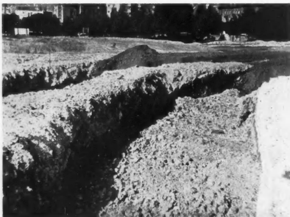
LA TERRE ARABLE EST DISPOSÉE DANS LES TRANCHÉES DRAINÉES
