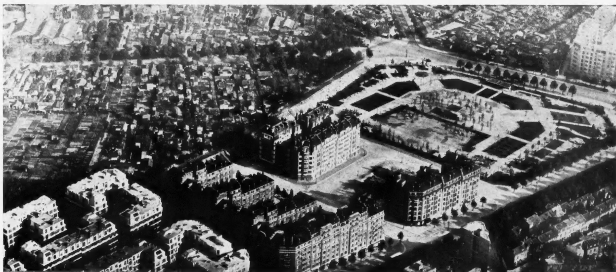
VUE AÉRIENNE DU SQUARE SÉVERINE - ARCHITECTE: ROGER LARDAT
