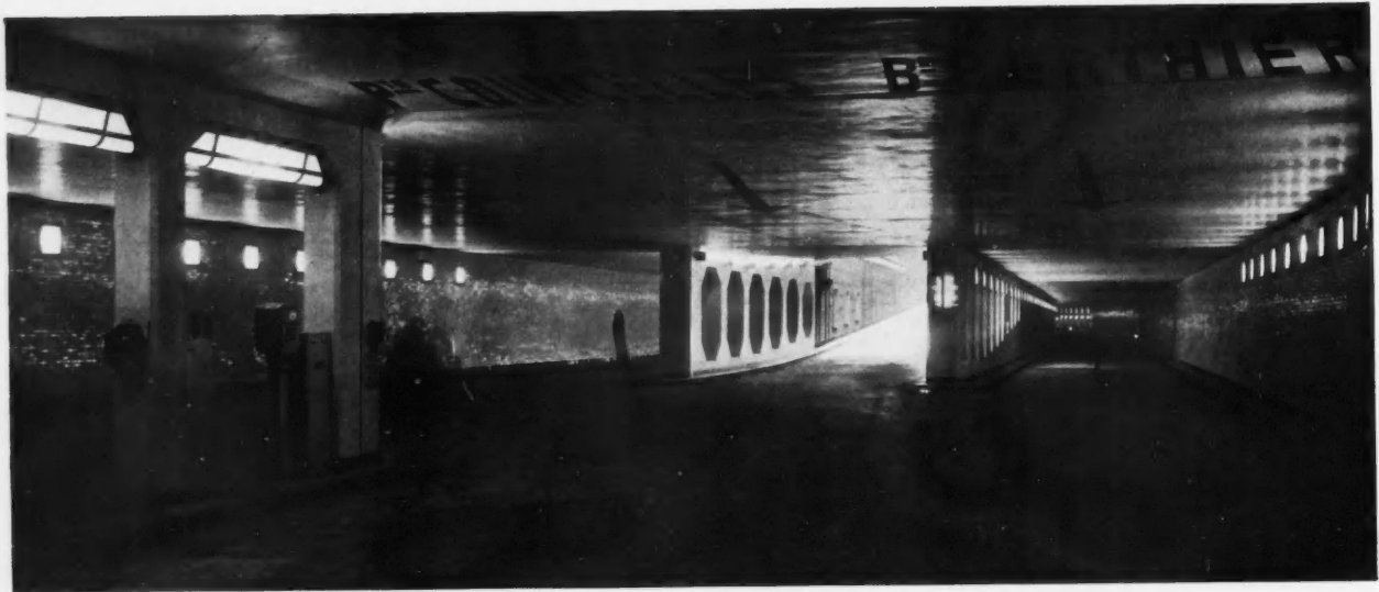
LE PASSAGE SOUTERRAIN DE LA PORTE CHAMPERRET. Eclairage par Clémanson.
