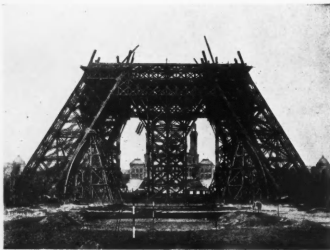
1889 LA TOUR EIFFEL EN CONSTRUCTION
