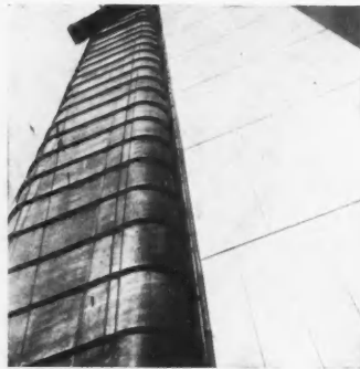
Revêtement en cuivre et en tôles pliées.
