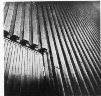
PAVILLON DE LA FINLANDE. Revêtement en lames de bois verticales vernies.
