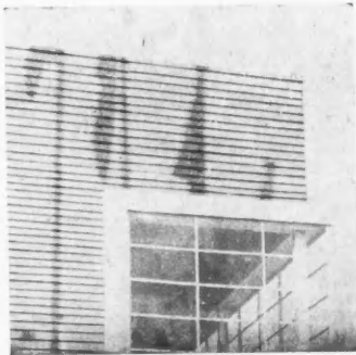
PAVILLON DU YACHTING. Clins horizontaux à recouvrement.
