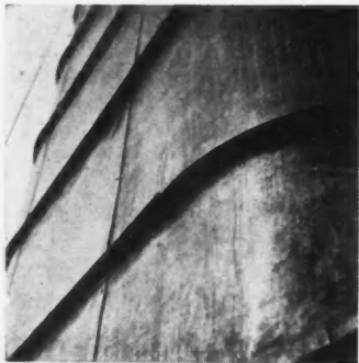
Détail du revêtement en cuivre ci-contre.
