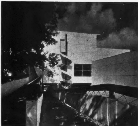
FAÇADE EST VUE DE LA RAMPE
