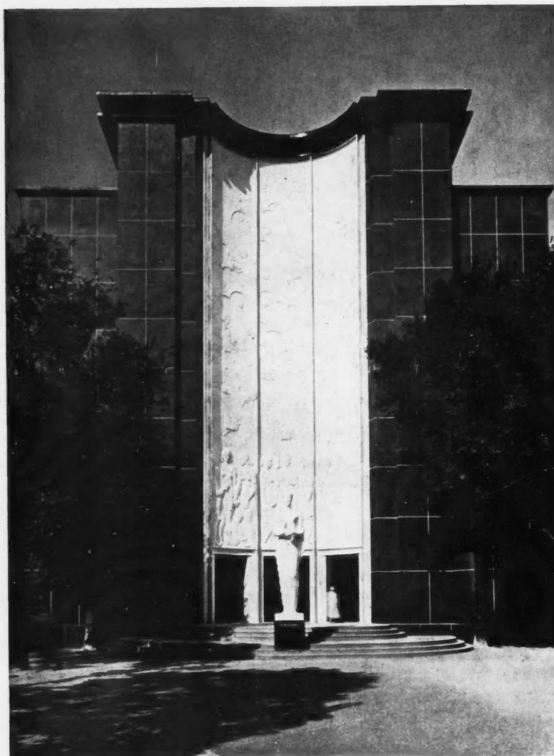
ENTRÉE PRINCIPALE ET FAÇADE EN GRANIT NOIR
