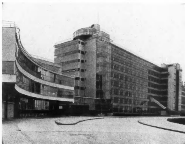
Important immeuble moderne dont la vitrerie verticale sur fenêtres métalliques est posée au STOPSTARA.
