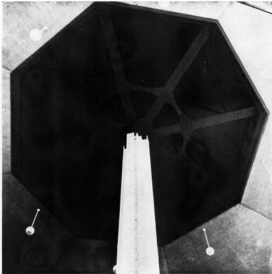
LE PLAFOND DE LA ROTONDE: ENRAYURES ET PLATEAU REPOSANT SUR LE POTEAU CENTRAL, SUPPORT UNIQUE DE CETTE PARTIE DU PAVILLON
