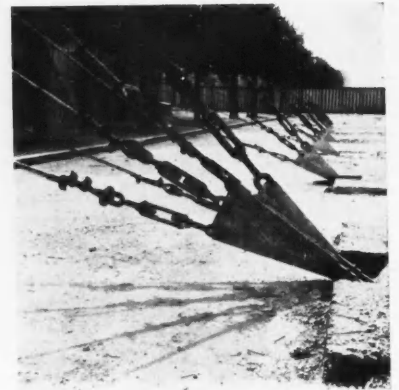
ANCRAGE DES CABLES
