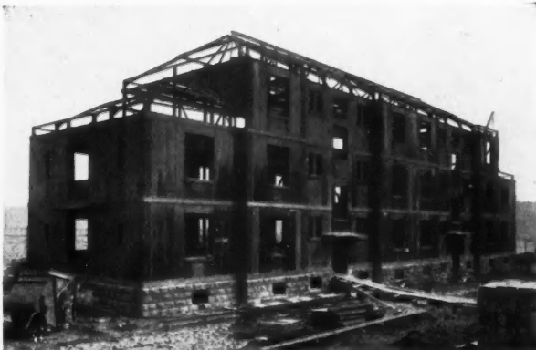
Fig. 4. - Construction d'un bâtiment du type « semi-métallique » à 2 étages, troisième phase.
