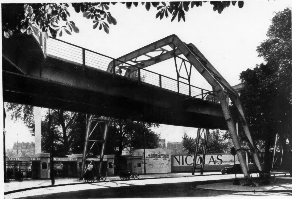
UN DES NEUF PORTIQUES AUXQUELS EST SUSPENDUE LA PASSERELLE
