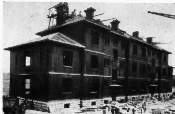
Fig. 5. - Construction d'un bâtiment du type « semi-métallique » à 2 étages, quatrième phase.
