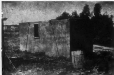
LIFT TRANSFORMÉ EN VILLA
