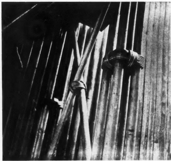
AUVENT D'ENTRÉE. POTEAUX EN BOIS RENFORCÉS D'OSIER
