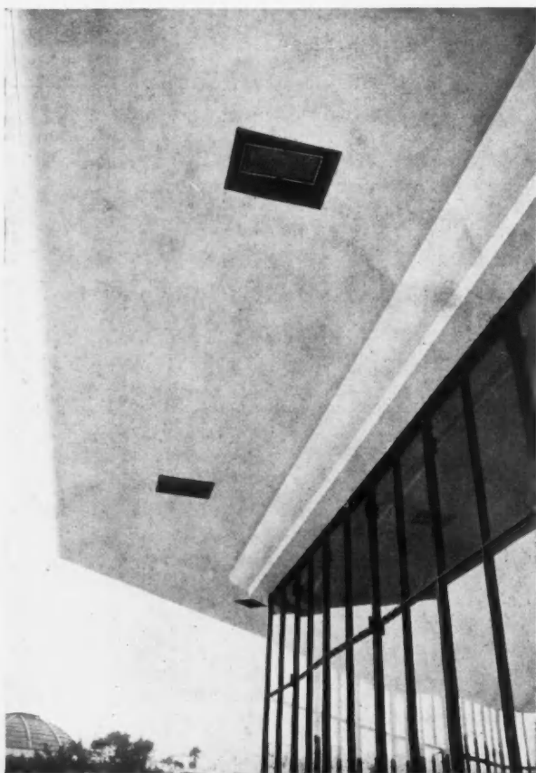
VUE DES ÉLÉMENTS RADIANTS COX POUR LE CHAUFFAGE DE LA TERRASSE DU RESTAURANT (prise par en-dessous)
