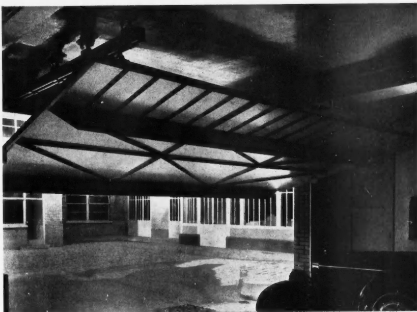
PORTE A RAILS TUBULAIRES DROITS AU PLAFOND, ET DEUX RAINURES LATÉRALES A GUIDAGE A BILLES. (Doc. Fossier-Allard)
