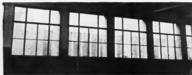
EXEMPLE DE CROISÉE EN PROFILS TUBULAIRES.
