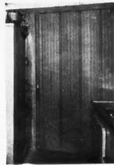
PORTES « ACCORDÉON » A DOUBLE PAROI ET CROISIL-LONS INTÉRIEURS.
