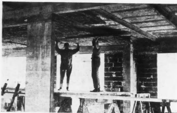
ISOLATION D'UN PLANCHER EN BÉTON-ARMÉ PAR DES PANNEAUX EN BAMBOUS-ROSEAUX DE PROVENCE. Doc. Christin.
