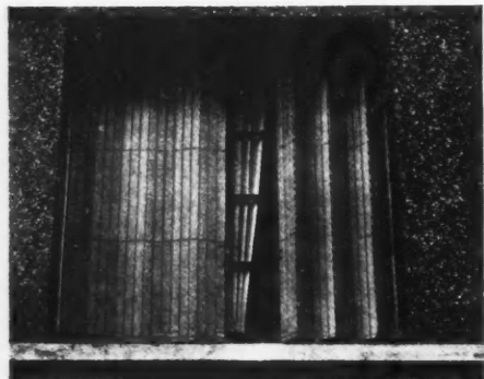
JALOUSIE SE REPLIANT EN ACCORDÉON, GUIDÉE HAUT ET BAS PAR DES ANNEAUX ENFILÉS SUR DES TRINGLES.
