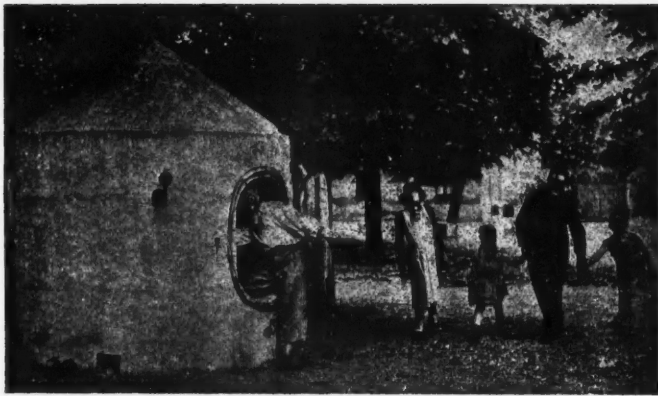
« ABRI MARCILLE » en béton, transportable. Hauteur totale: 2 m. 40; diamètre: 1 m. 80; épaisseur de béton: 17 cm. Un tel abri peut être coulé en quatre heures. (Voir photo ci-contre)
