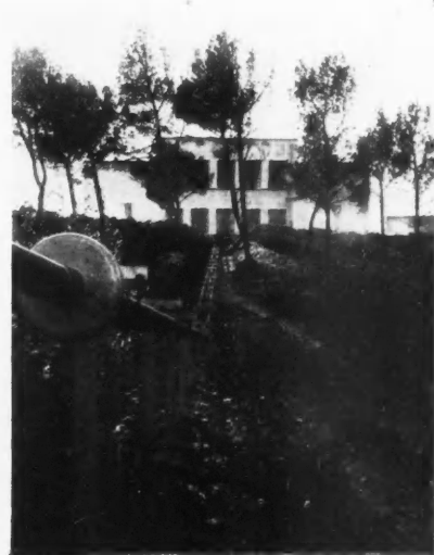
Vue du feeder de Marseille P.T.T. (Les feeders ont pour but de transmettre la puissance haute fréquence du poste à l'antenne).
