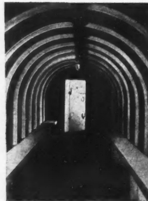
soutènement métallique français système Marchak
