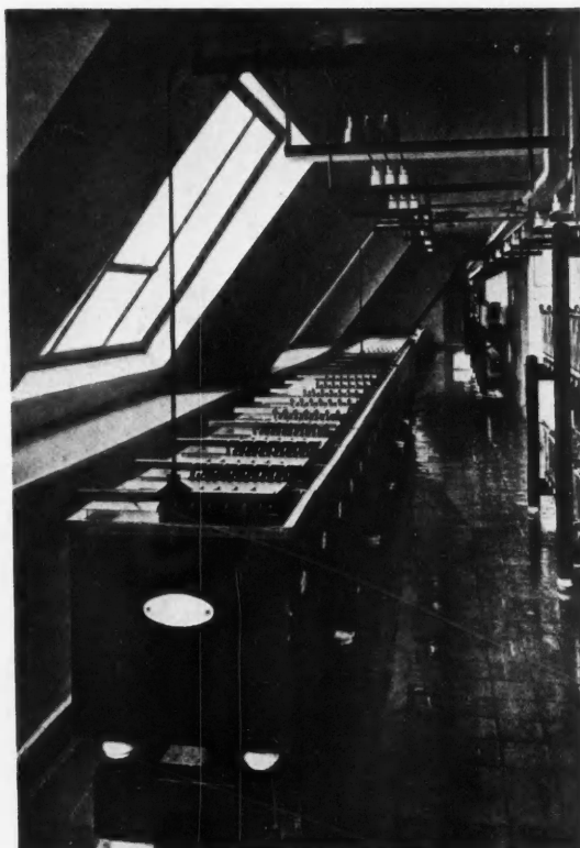
LA SALLE DES ACCUMULATEURS, RELIÉE A LA CABINE DE COMMANDE
