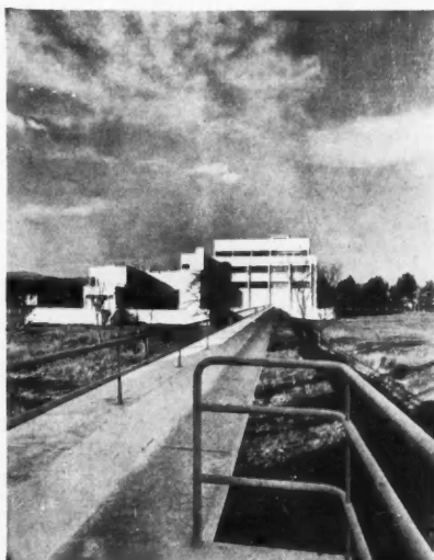
Poste de Nice. Vue générale prise de la passerelle en béton armé reliant la station au pylône. Cette passerelle supporte les feeders alimentant le pylône (voir ci-contre).
