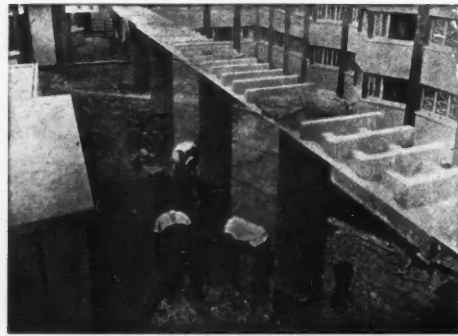
IMMEUBLE DE RAPPORT, 13, PLACE DE VAUGIRARD
