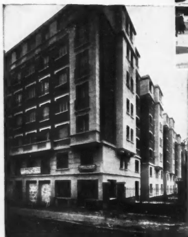
Toitures-Terrasses d'un groupe d'immeubles, 33, rue de l'Amiral-Mouchez, Paris. Couvertes en Ruberoïd. M. Béguet, Architecte. M. Barba, Entrepreneur de Couverture. Contrôle Veritas. 1934
