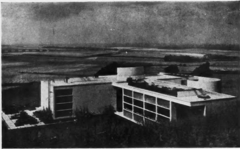
VUE DU CÔTÉ DE L'ENTRÉE
