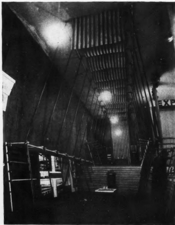
PRÉSENTATION D'ÉCHAFAUDAGES TUBULAIRES MILLS A L'ENTRÉE DE L'EXPOSITION DE L'HABITATION. ARCHITECTE: PIERRE VAGO
