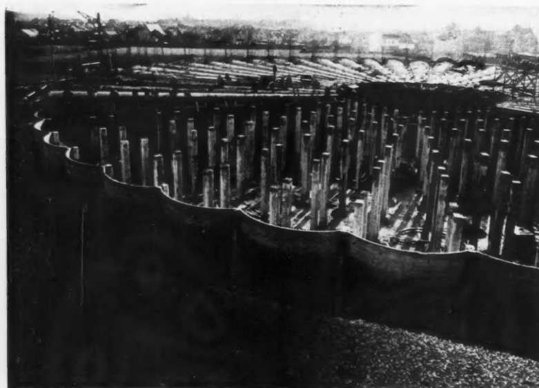
CONSTRUCTION DU FOND ONDULÉ DU COMPARTIMENT DU PREMIER ÉTAGE.
