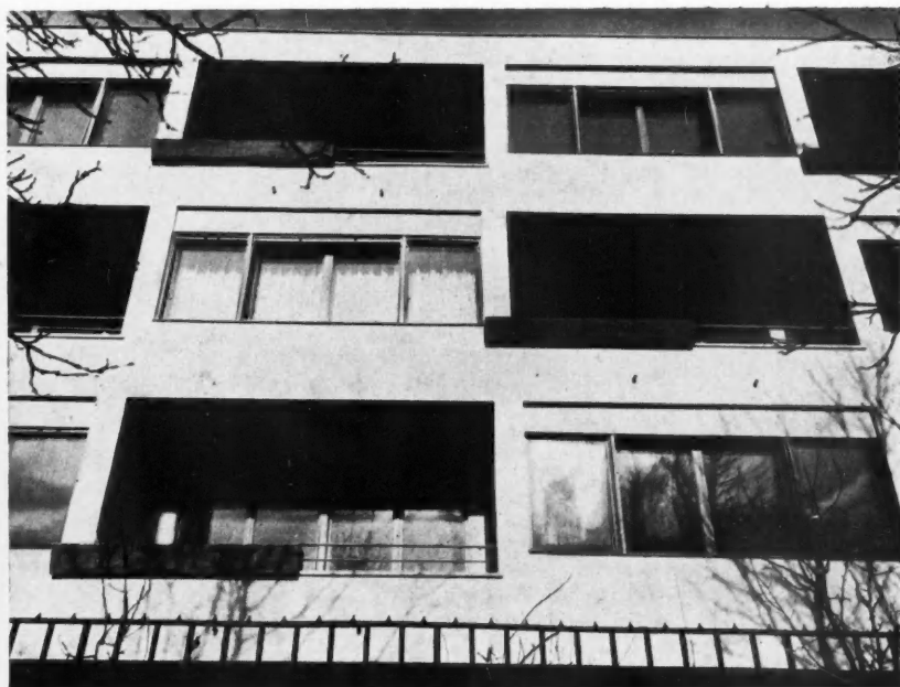
DÉTAIL DE LA FAÇADE
