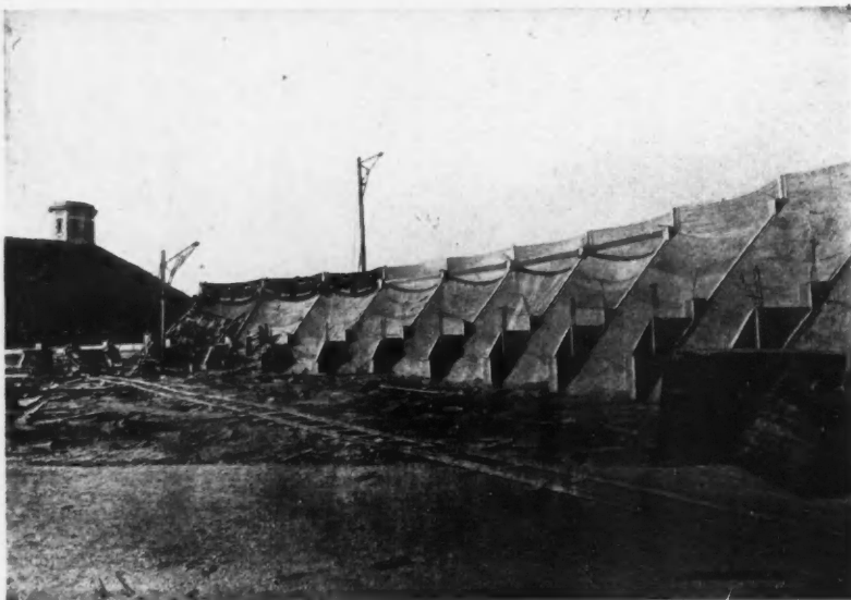
COMPARTIMENT INFÉRIEUR DE LA PAROI DE RETENUE (INTÉRIEUR)
