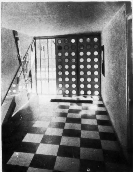
ENTRÉE DE L'IMMEUBLE
