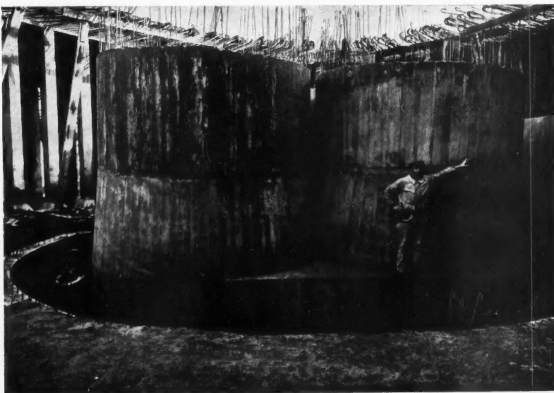
LES VANNES APRÈS DÉMOULAGE.
