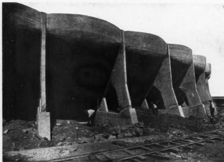
COMPARTIMENT INFÉRIEUR DE LA PAROI DE RETENUE (EXTÉRIEUR)
