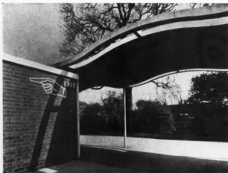
L'AUVENT VU DE L'ENTRÉE DU JARDIN
