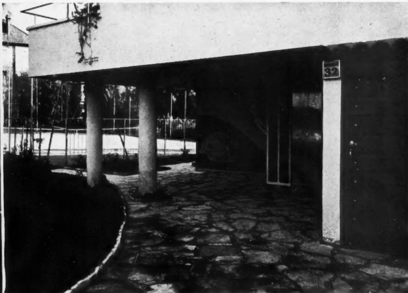
ENTRÉE DE LA VILLA
