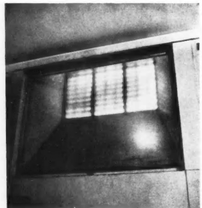
ÉLARGISSEMENT DES SOUPIRAUX ÉCLAIRANT LES SOUS-SOLS EN BORDURE DE LA RUE DE RICHELIEU Les dessins correspondent aux nouveaux magasins en sous-sol (poteaux C7 et C8) et montrent l'éclairage du 2 e sous-sol par caillebotis métallique. La photographie ci-contre montre un des soupiraux éclairant le vestibule du catalogue public.
