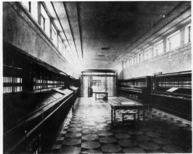
LA GALERIE DU CATALOGUE GÉNÉRAL, SERVANT D'ACCÈS A LA GRANDE SALLE DE LECTURE
