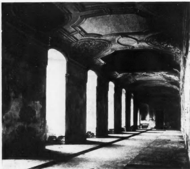
ETAT ACTUEL DES TRAVAUX (FÉVRIER 1938)
