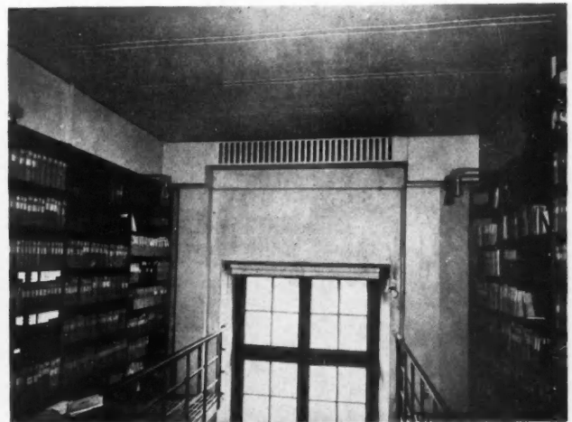
DIFFUSEUR DANS UN DES MAGASINS DE LIVRES, EN BORDURE DE LA RUE DE RICHELIEU
