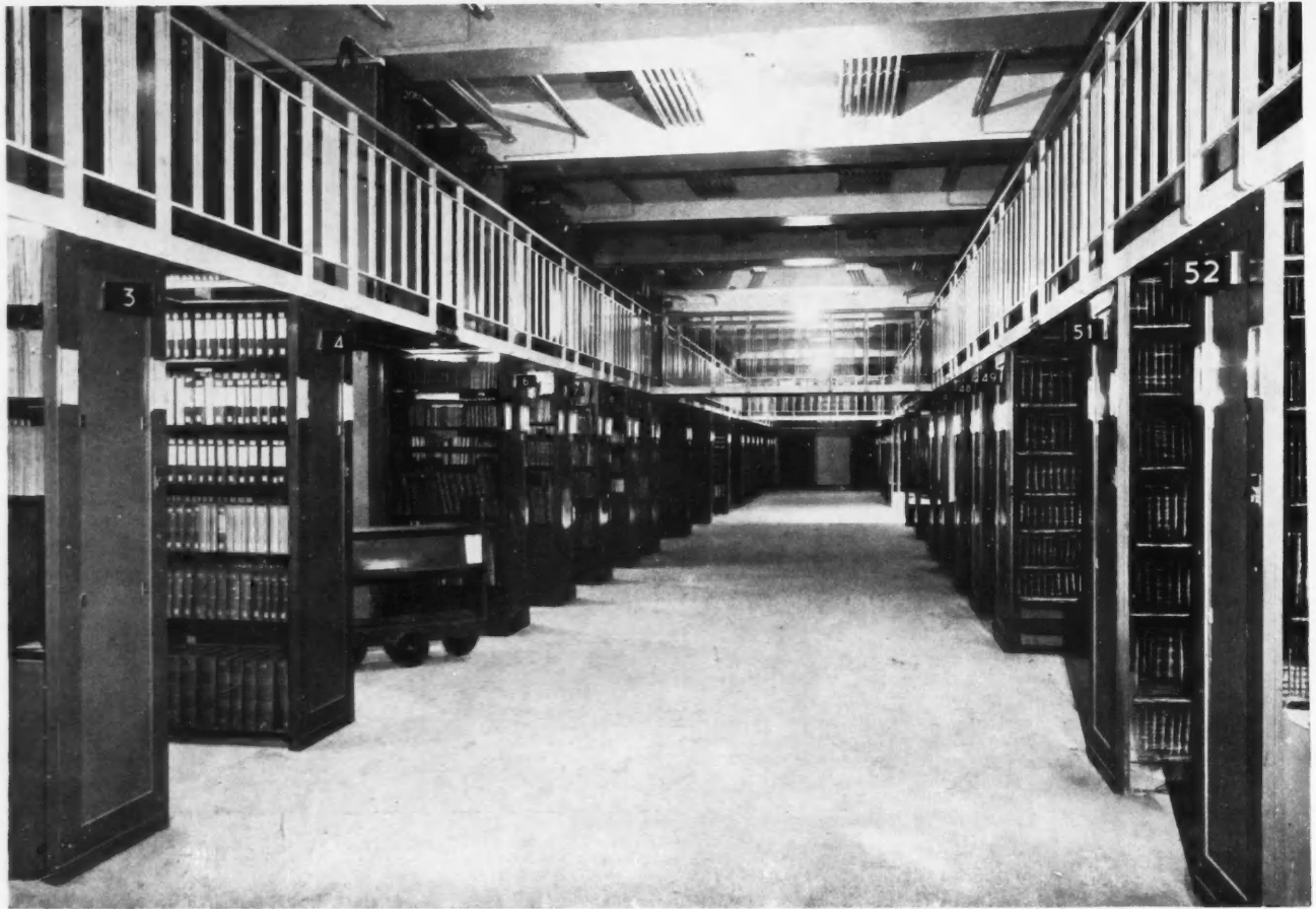
BIBLIOTHÈQUE NATIONALE DE PARIS. VUE D'ENSEMBLE DES NOUVEAUX MAGASINS EN SOUS-SOL
