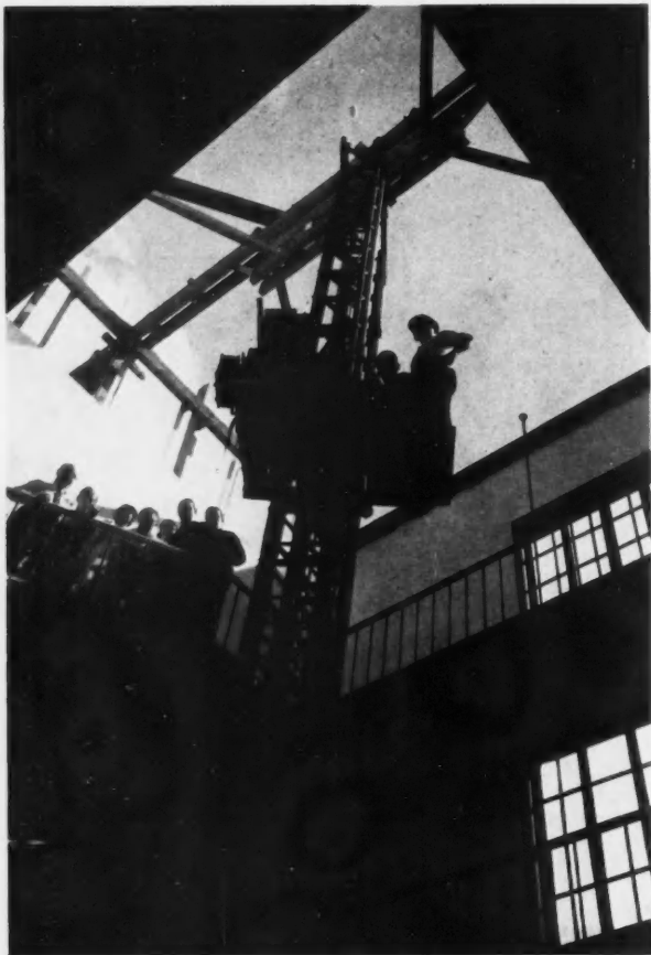
ASCENSEUR POUR PRISES DE VUES: levée: 12 mètres.
