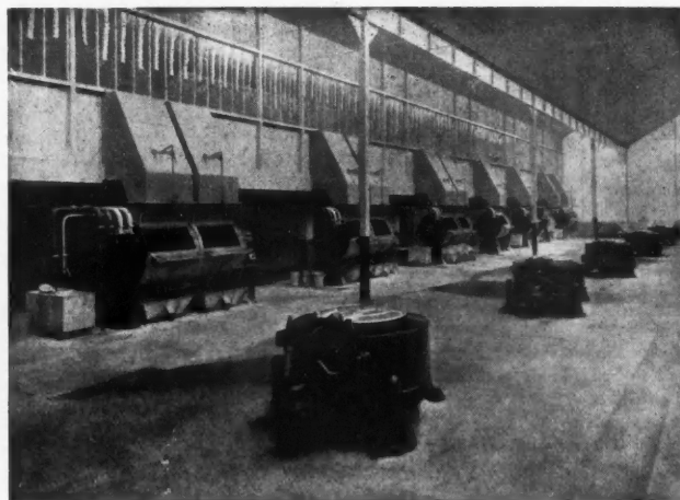
MACHINES A LAYER alimentées directement par les trémies. Au premier plan: essoreuses rotatives.
