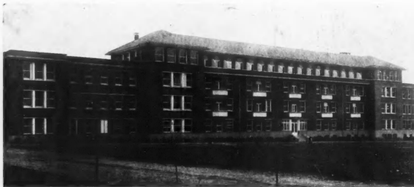
BATIMENT PRINCIPAL. FAÇADE SUD
