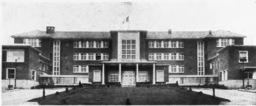
BATIMENT PRINCIPAL. FAÇADE NORD
