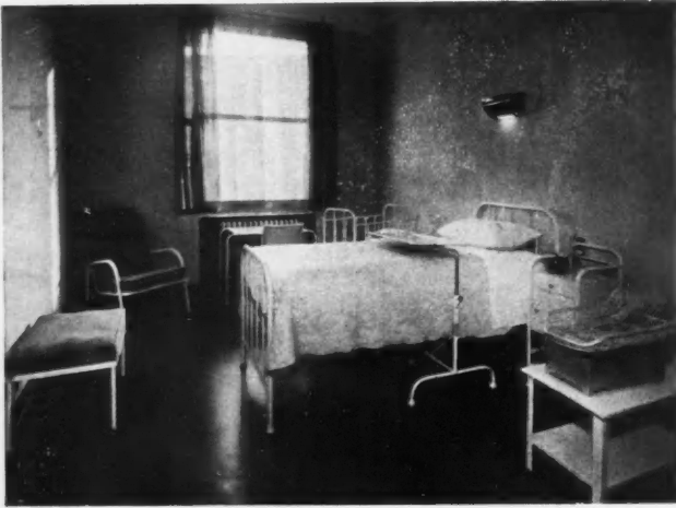
LA FONDATION FOCH CHAMBRE DE MALADE. Linoléum SARLINO uni havane 3 mm. 5. E. FOUQUÉ, ARCHITECTE
