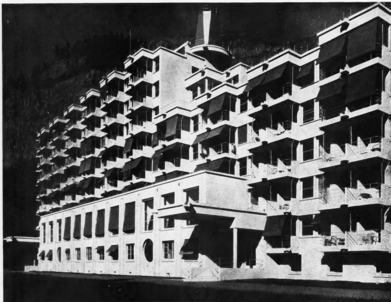
SANATORIUM «GEOFFROY DE MARTEL DE JANVILLE» A PASSY (HAUTE-SAVOIE), ALTITUDE: 1.050 M. P. ABRAHAM ET H. LE MÊME, ARCH.
