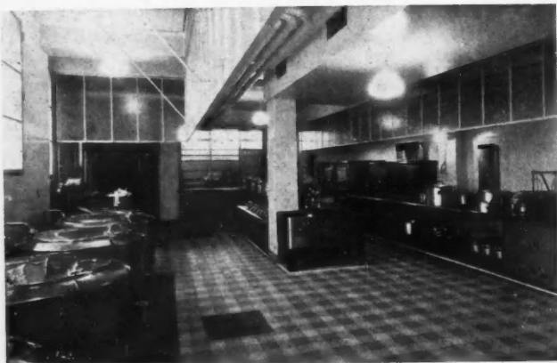
Doc. Bergerand de Joly HOPITAL DE CRÉTEIL: LA CUISINE
