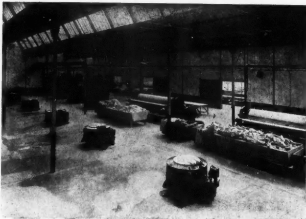
BACS DE FRAUDAGE et machines à repasser.
