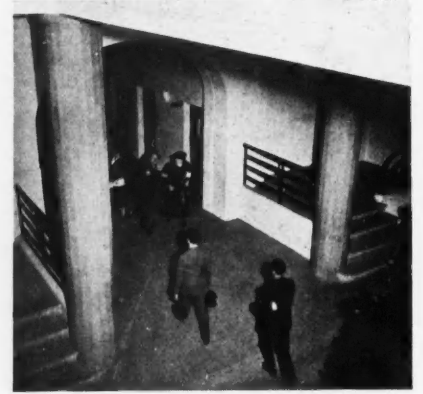
ASCENSEURS DES VISITEURS
