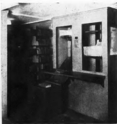
5 Convoyeur à livre. 5: Poste de départ (chaîne montante) et poste de réception (chaîne descendante). Le livre est reçu dans une sorte de sac. 6. Pour les ouvrages précieux, un dispositif permet la réception sans chocs sur un plateau mobile équilibré de telle manière que le poids d'un livre le fasse enfoncer de son épaisseur. De cette manière, un livre arrivant immédiatement après vient se poser sur le premier. 7: Vue d'un convoyeur dans une partie horizontale. Photos Sneed
