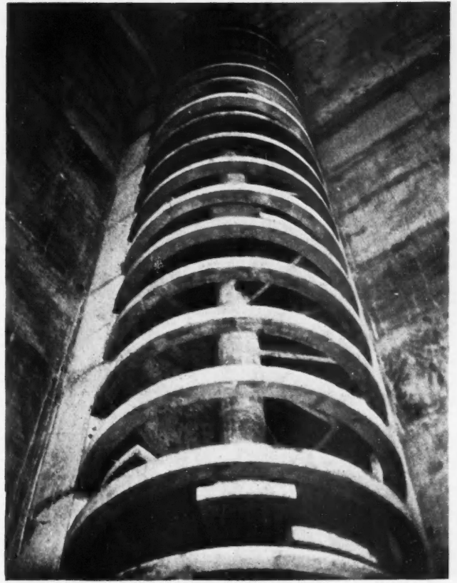
OSSATURE D'ESCALIER TOURNANT
