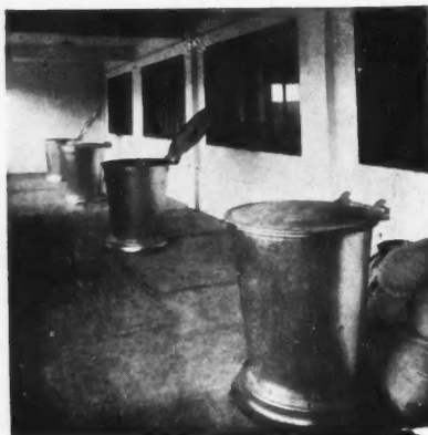
Celles-ci, chargées du haut comme un convertisseur d'aciérie, évacuent en fin de lavage, le linge dans des trémies en liaison avec les essoreuses placées sous les machines.
