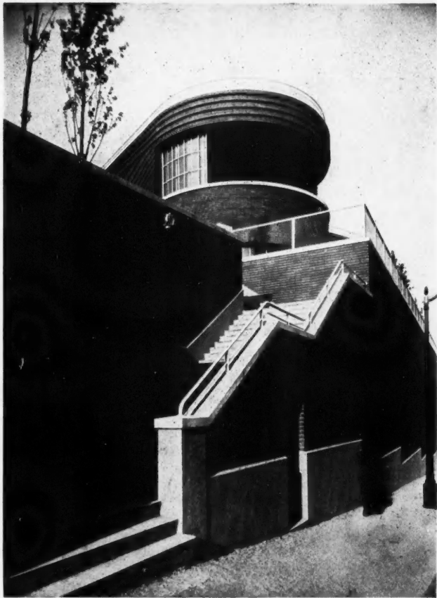
EXTRÉMITÉ DE L'ÉCOLE MATERNELLE CLASSE 6). LE PORTE-A-FAUX DE LA PARTIE ARRONDIE PERMET LE DÉGAGEMENT TOTAL DE LA BAIE
