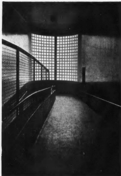
LA RAMPE D'ACCÈS DE LA MATERNELLE
