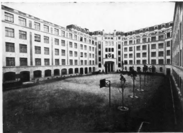
LYCÉE DE GARÇONS A AUTEUIL
