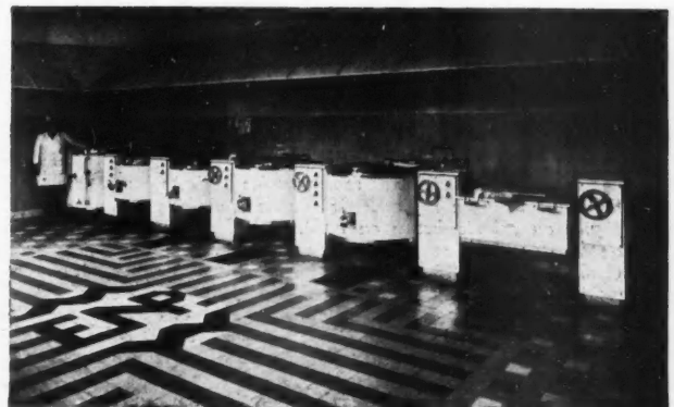
CUISINE DE METZ: de gauche à droite: percolateur, marmite à lait, marmites de 100, 200 et 300 litres, sauteuse.
