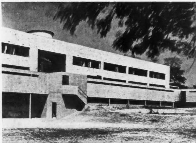
PARTIE CENTRALE FAÇADE SUD. AMORCE D'UNE 3 e AILE DE CLASSES
