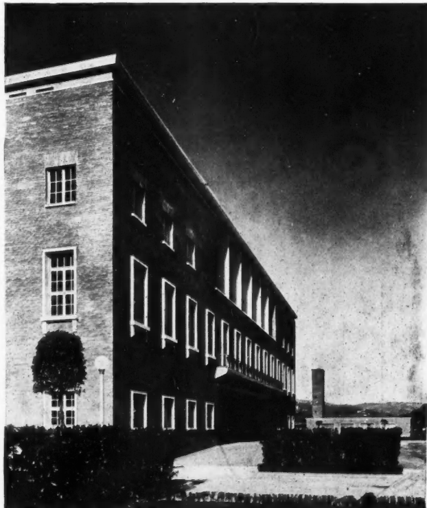
BATIMENT DE DIRECTION, FAÇADE VERS L'ÉCOLE
