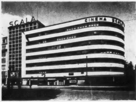
FAÇADE DE L'IMMEUBLE « SCALA »
