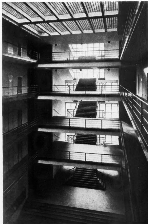
GRAND HALL CENTRAL AVEC L'ESCALIER PRINCIPAL
