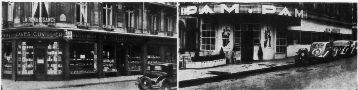
LA FAÇADE AVANT ET APRES LES TRAVAUX
