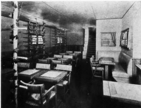
VUE DU FOND DE LA SALLE
