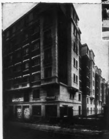
Toitures-terrasses d'un groupe d'immeubles, 33, rue de l'Amiral-Mouchez, Paris. Couvertes en Ruberoid. M. Béguet, Architecte. M. Barba, Entrepreneur de Couverture. Contrôle Veritas. 1934
