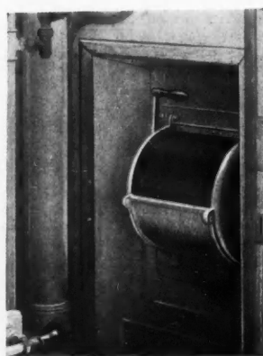
Vidoir à tambour dans une cuisine, manœuvre à la main.
