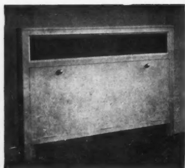
CONVECTOR, installé dans un bureau
