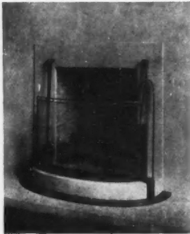
Cheminée. Foyer et entourage en pierre, pare-feu en gaze métallique. (Voir aussi page 22).
