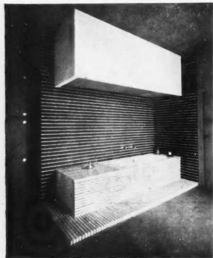
Baignoire et bidet escamotable revêtus de briquettes blanches. Murs revêtus de briquettes nègre, plafond et placard revêtus de liège. Arch. J. ROYÈRE. Editeur : GOUFFÉ
