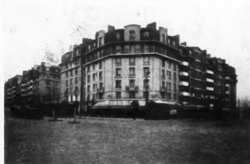
PARIS - Groupe d'immeubles de la porte de Montreuil (Société Anonyme de Gestion Immobilière).
