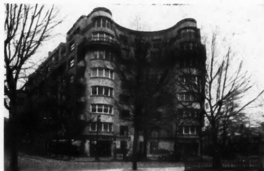
PARIS - Groupe d'immeubles du Rond-Point Mirabeau (Mutuelle Générale Française).
