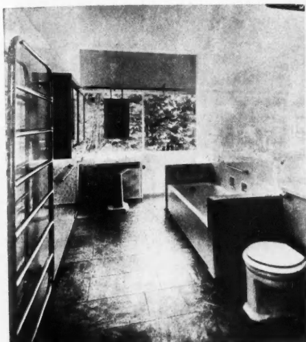
Salle de bains : Au-dessus du lavabo, glace argentée coulissante; à gauche, armoire-pharmacie et séchoir à linge. Arch. GINSBERG et HEEP
