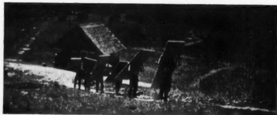
Tous les éléments de la construction sont assez légers pour pouvoir être portés facilement par un homme.
