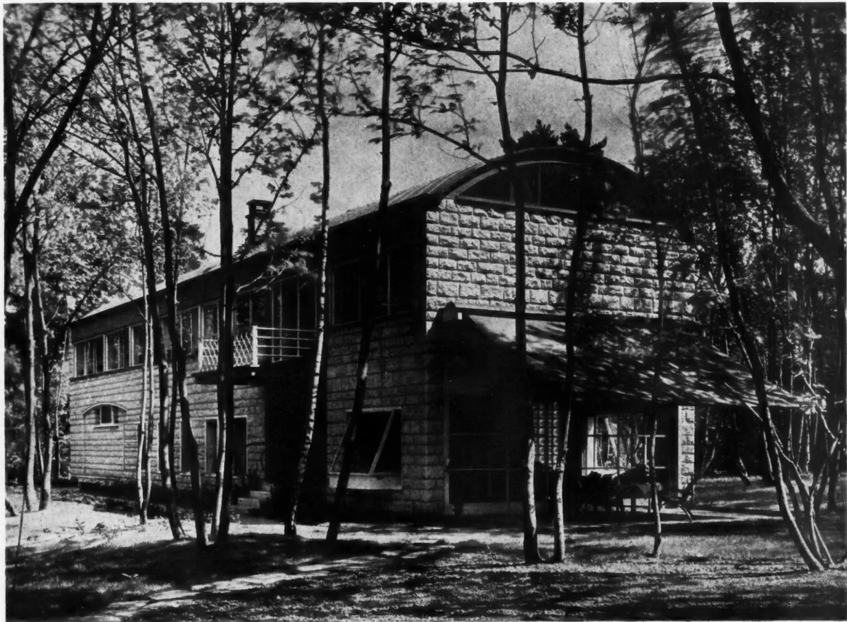
VILLA A LA CELLE-SAINT-CLOUD, FAÇADE OUEST ET FAÇADE SUD
