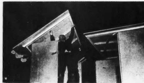
MONTAGE DU TOIT
