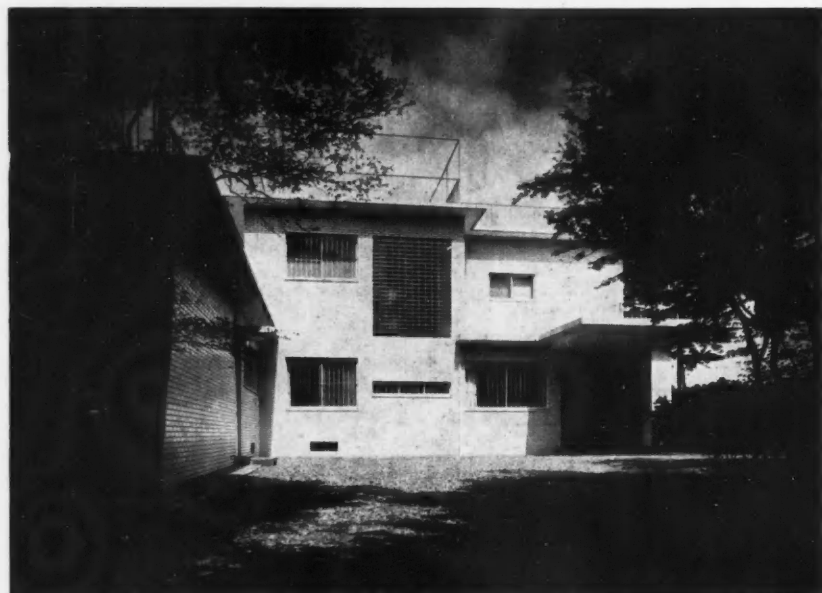
FAÇADE OUEST : ENTRÉE. GRAND VITRAGE DE L'ESCALIER ET SERVICES
