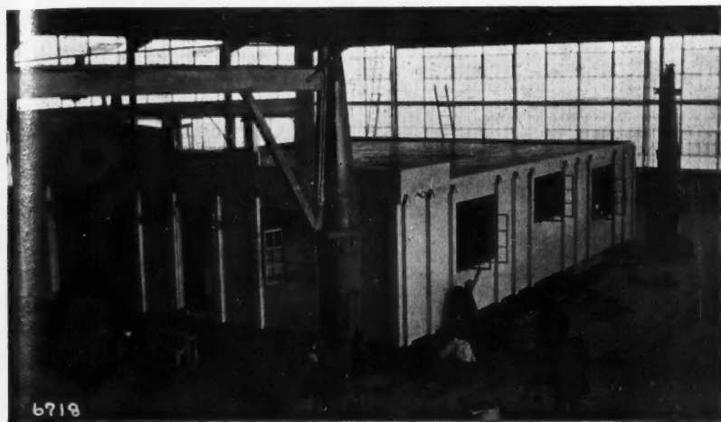
CONSTRUCTION A L'ATELIER
