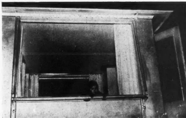
UNE DES DEUX GRANDES FENETRES
