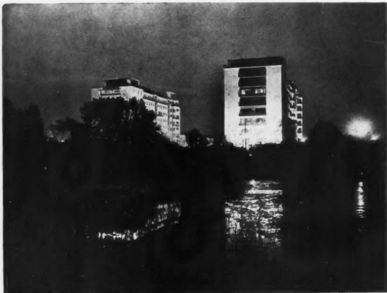
DEUX DES IMMEUBLES PRÈS DE LA MER
