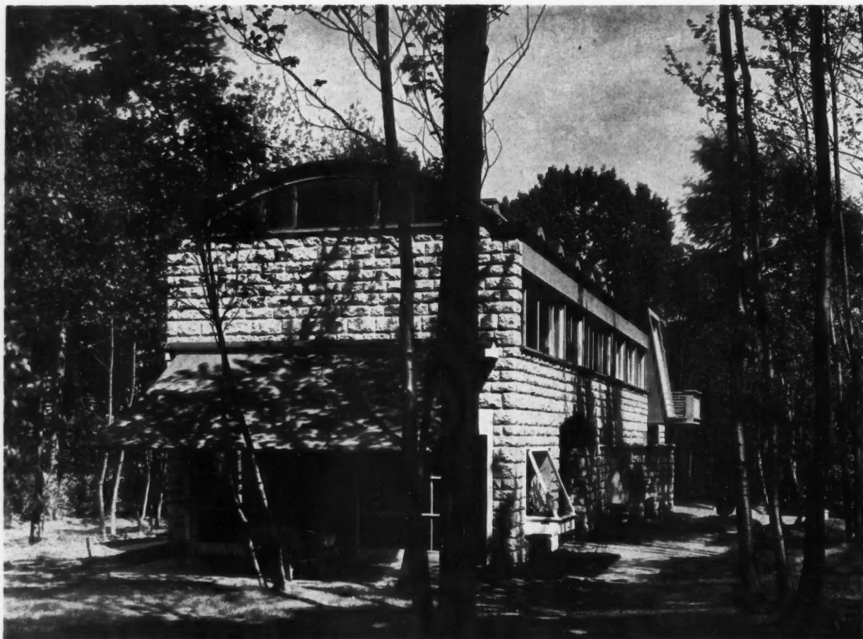
VILLA A LA CELLE-SAINT-CLOUD FAÇADE SUD ET FAÇADE EST
