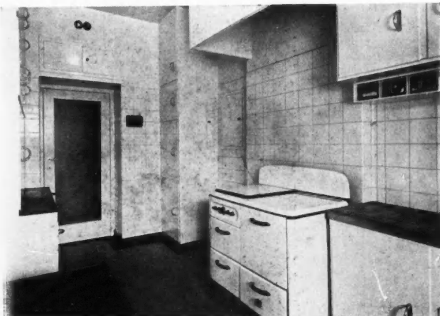
UNE CUISINE ELECTRIQUE A PLACARDS STANDARDISÉS
