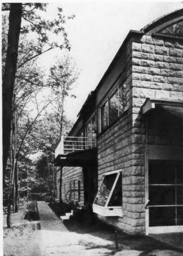
FAÇADE OUEST : ENTRÉE
