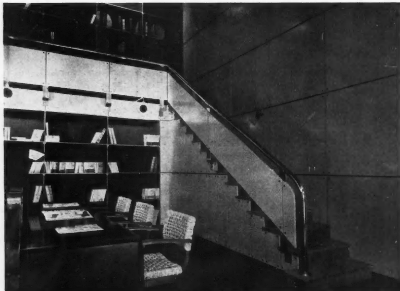
UN COIN DE LA SALLE DE LECTURE. Marches, contre-marches et rampe en fibro-ciment. Murs : Granitelo coquille d'œuf, joints noirs.
