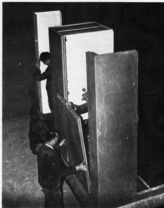
MONTAGE DES MURS
