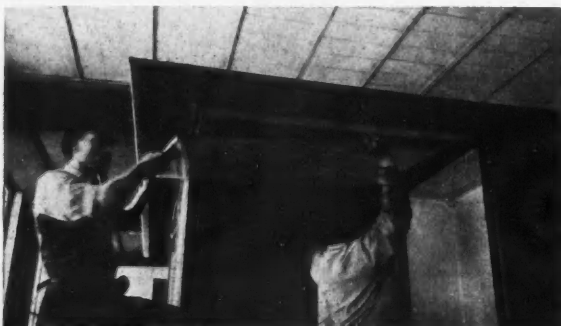
DOUBLAGE DU PLAFOND
